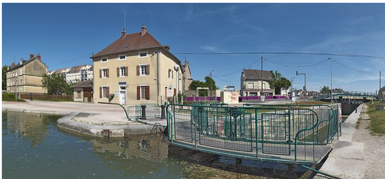
Façade de la maison éclusière donnant sur le port. A droite, le sas. Sur la gauche, on aperçoit la maison de perception.
