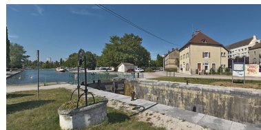
Façade de la maison éclusière donnant sur le sas. Remarquez l'ordonnancement des ouvertures du rez-de-chaussée, identique sur les maisons éclusières voisines. La maison de Dijon, trop petite, a été agrandie et surhaussée, mais le rez-de-chaussée de la façade sur canal a été conservé tel quel.
