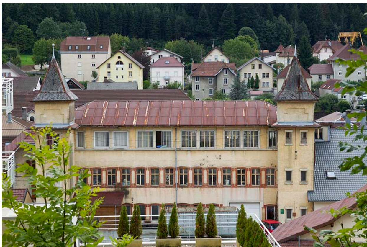
Usine : façade postérieure, vue en plongée.
