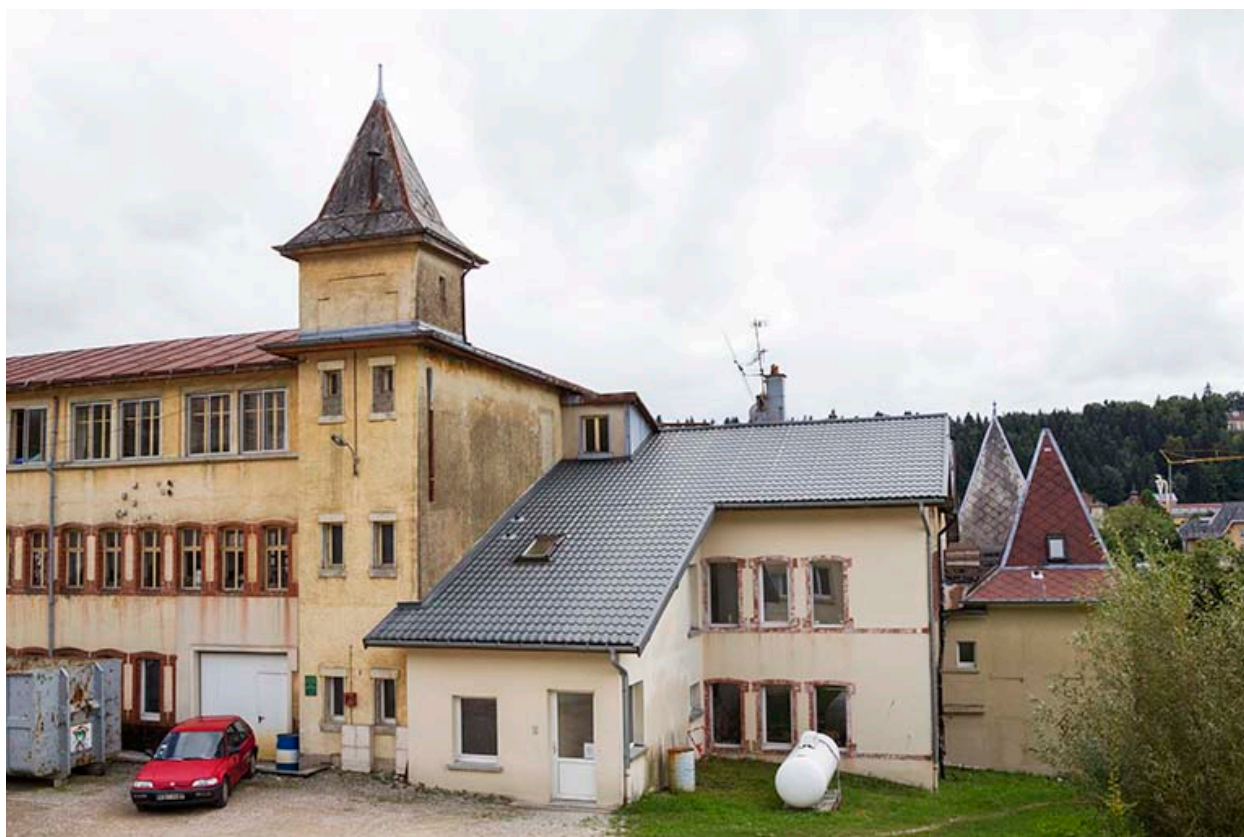
Atelier : façade nord.
