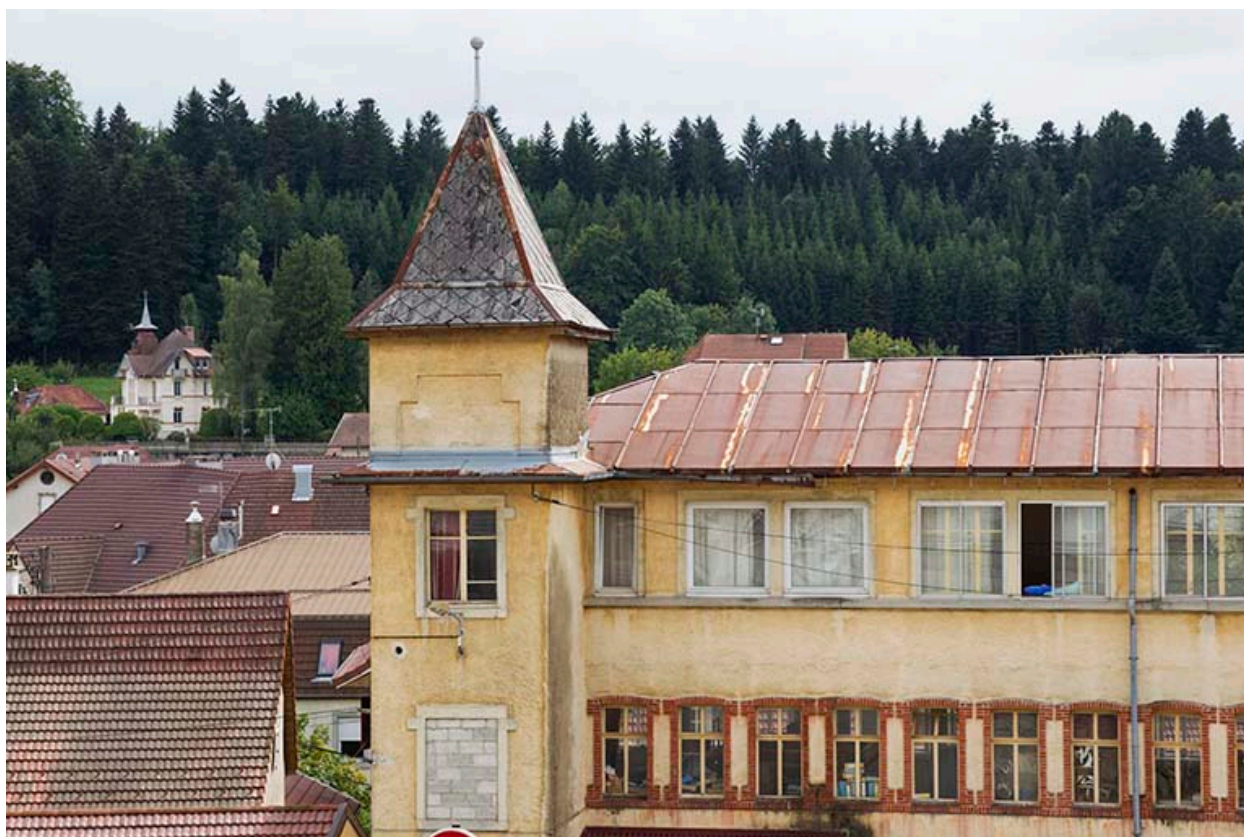
Usine, façade postérieure : tour orientale.
