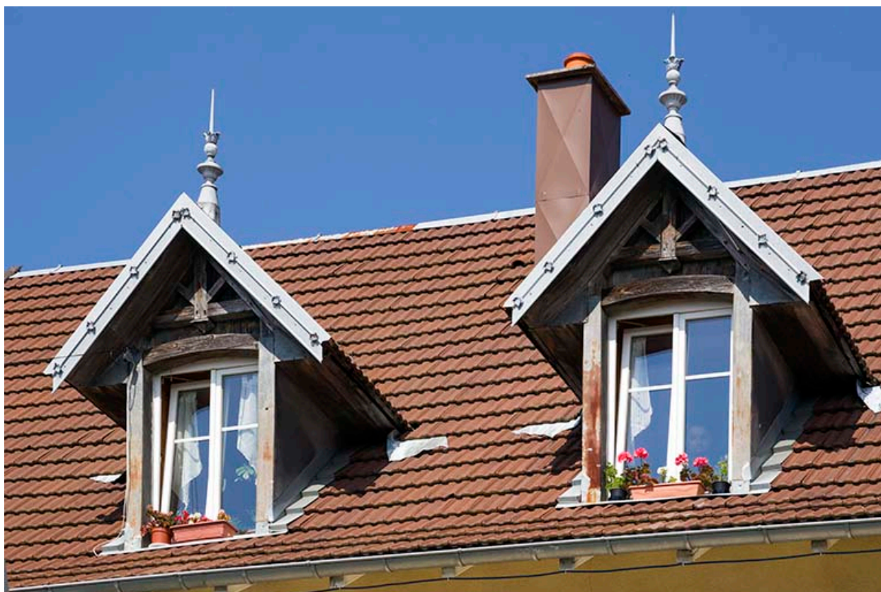
Logement patronal, façade latérale gauche : lucarnes.
