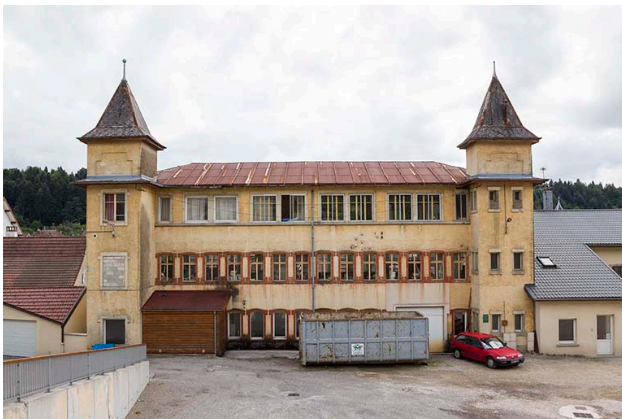
Usine : façade postérieure.
