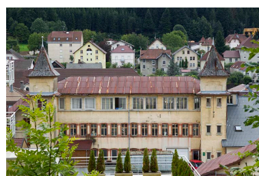
Usine : façade postérieure, vue en plongée.
