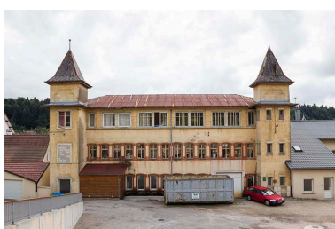
Usine : façade postérieure.
