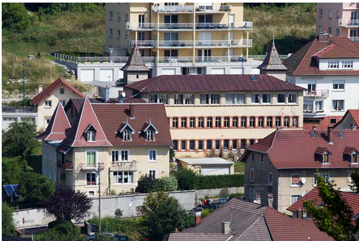
Vue d'ensemble plongeante, depuis le sud.
