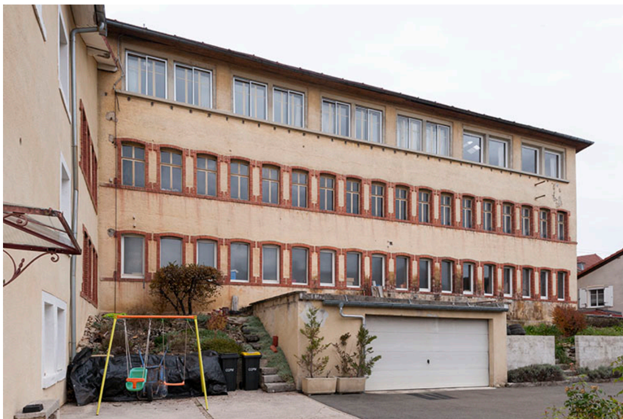
Usine : façade antérieure (sud).
