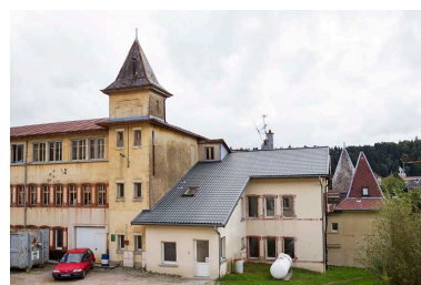
Atelier : façade nord.
