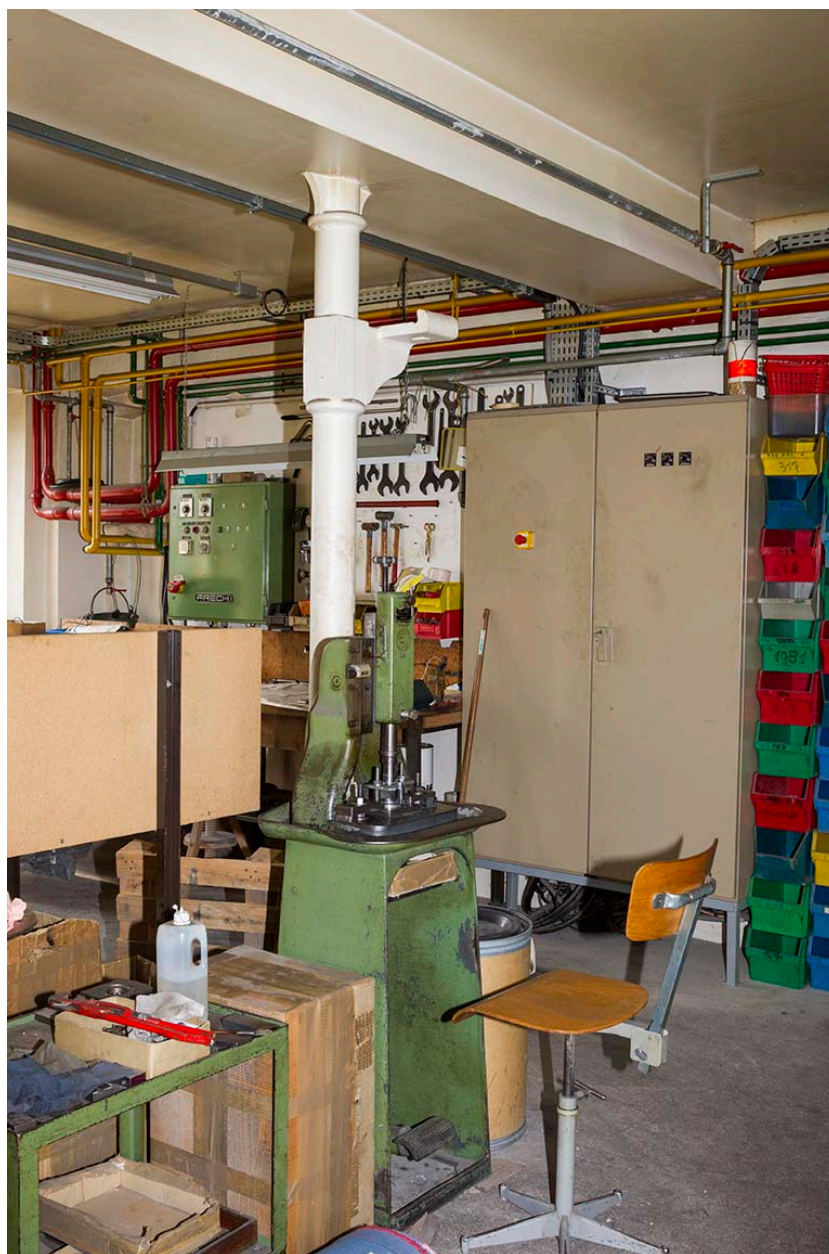
Usine, rez-de-chaussée : poteau de soutènement de l'étage.
