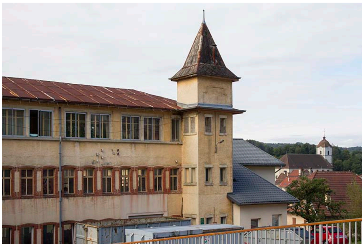
Usine, façade postérieure : tour occidentale.
