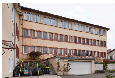
Usine : façade antérieure (sud).
