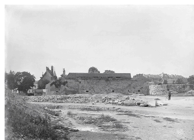
Démolition du château. [1890-1897]. Autr. auteur inconnu IVR26_20252100049NUC4A
