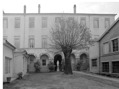
Bâtiment annexe, façade sur la cour.
