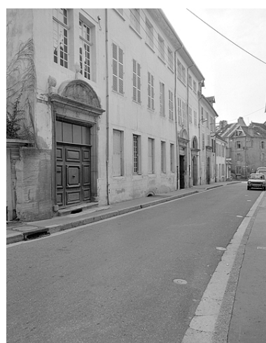
Façade sur la rue Sébile. Phot. Yves Sancey IVR43_19833900404X
