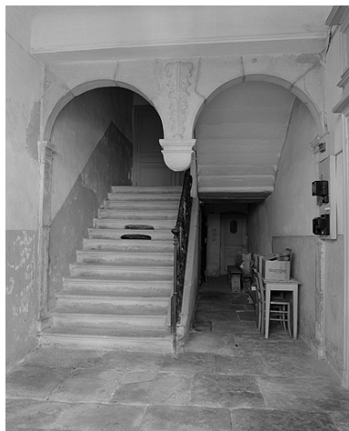
Escalier intérieur dans le corps de bâtiment sur rue, vue générale.
