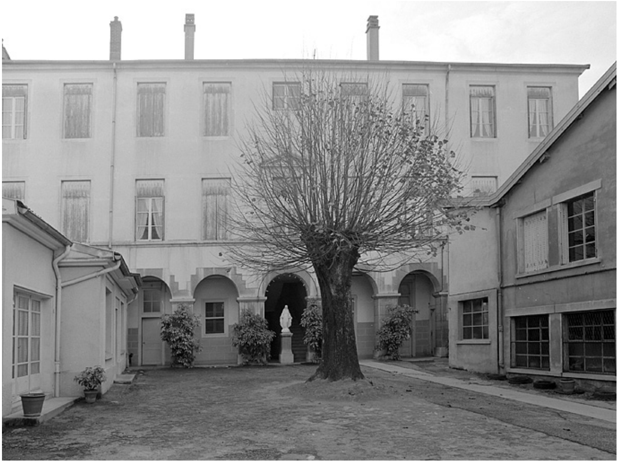
Bâtiment annexe, façade sur la cour.
