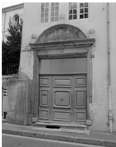
Façade sur la rue Sébile, portail gauche. Phot. Yves Sancey IVR43_19833900405X
