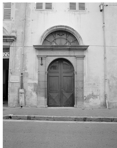
Façade sur rue Sébile, portail de la chapelle. Phot. Yves Sancey IVR43_19833900619X
