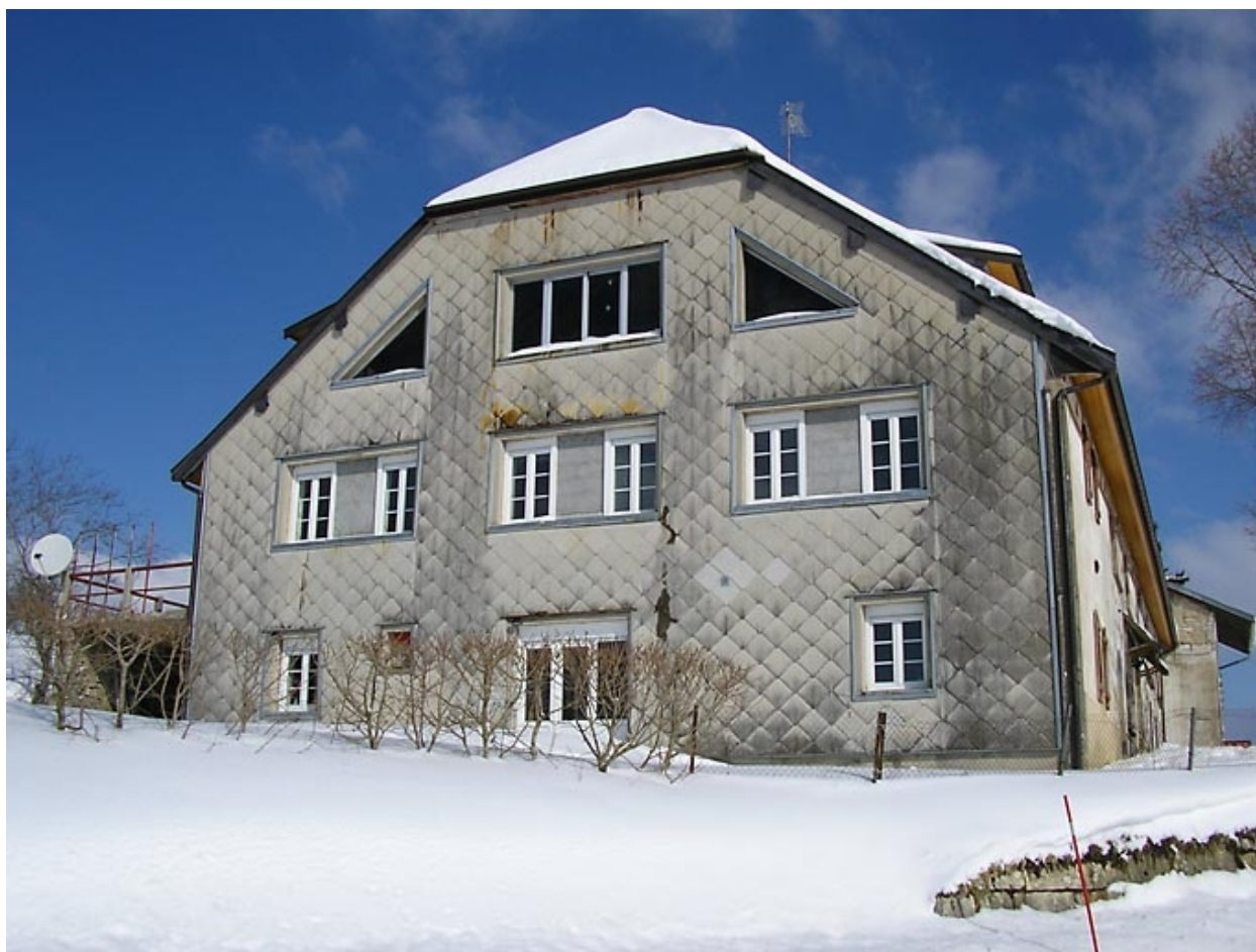
Vue générale du pignon sud-ouest.
