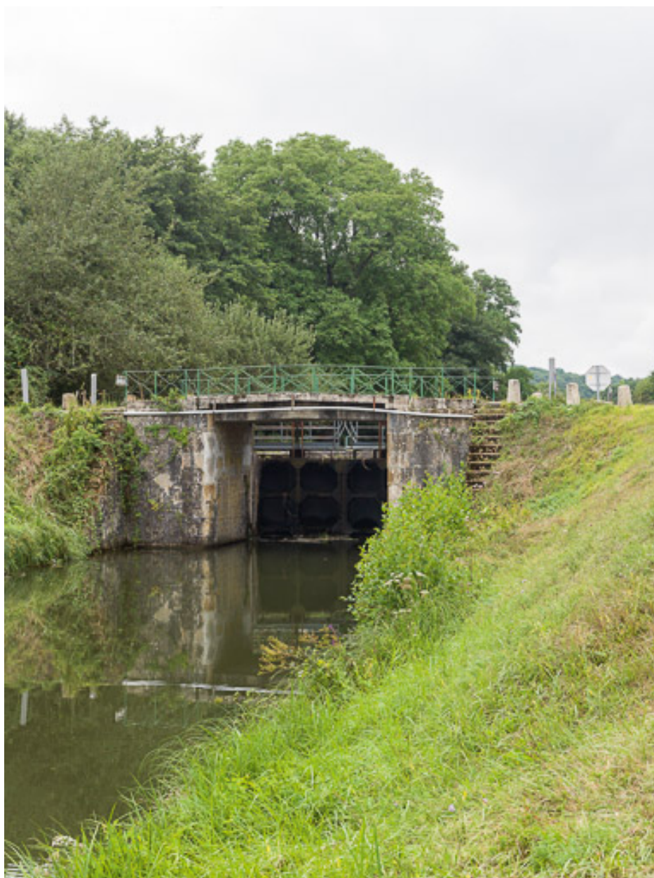
Vue d'ensemble du pont.
