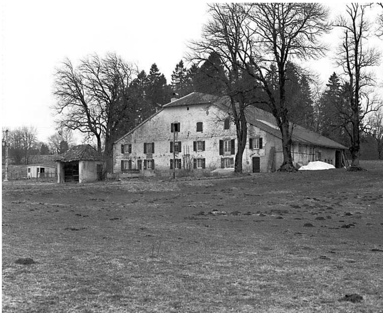
Ferme située au lieudit Forbonnet : vue d'ensemble.
