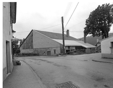
Ferme située 3 rue du Jura : vue d'ensemble. Phot. Yves Sancey IVR43_19782500512X
