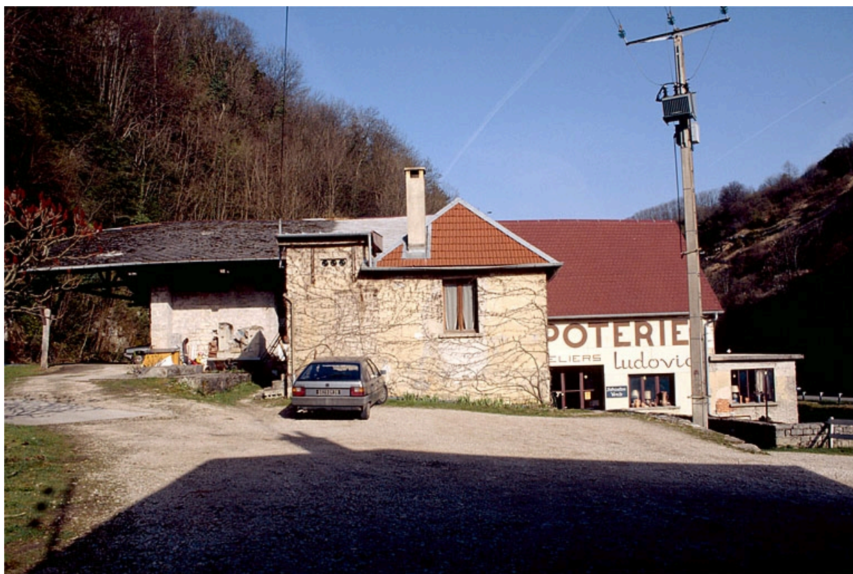
Vue depuis la cour. De gauche à droite : pièce de séchage, transformateur, salle des machines, atelier de fabrication et bâtiment d'eau.
