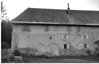
Un bâtiment. IVR43_19682500100Z
