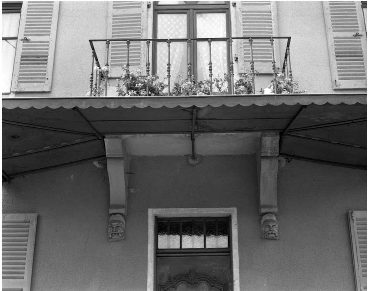
Détail du balcon.
