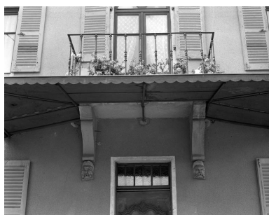
Détail du balcon. Phot. Yves Sancey IVR43_19917000399X
