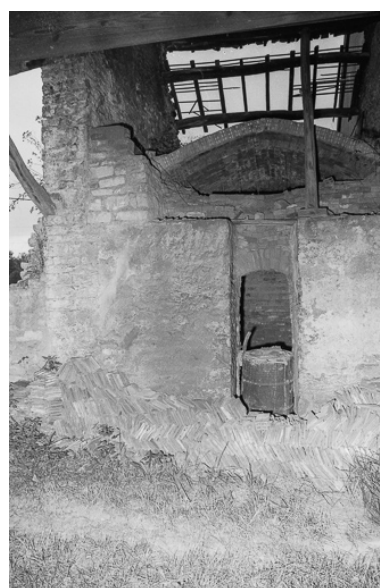
Façade antérieure du four. Phot. Bernard Lardière IVR43_19797000307Z
