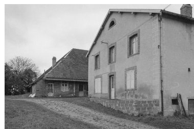
Maison d'habitation. Phot. Bernard Lardière IVR43_19797000297Z
