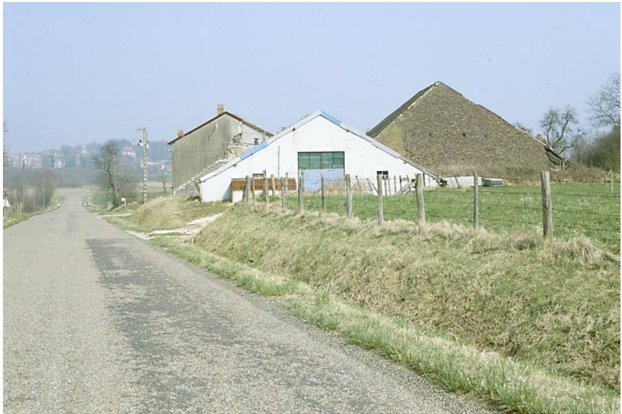
Vue d'ensemble depuis la route.
