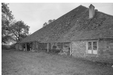
Séchoir : façade antérieure. Phot. Bernard Lardière IVR43_19797000298Z
