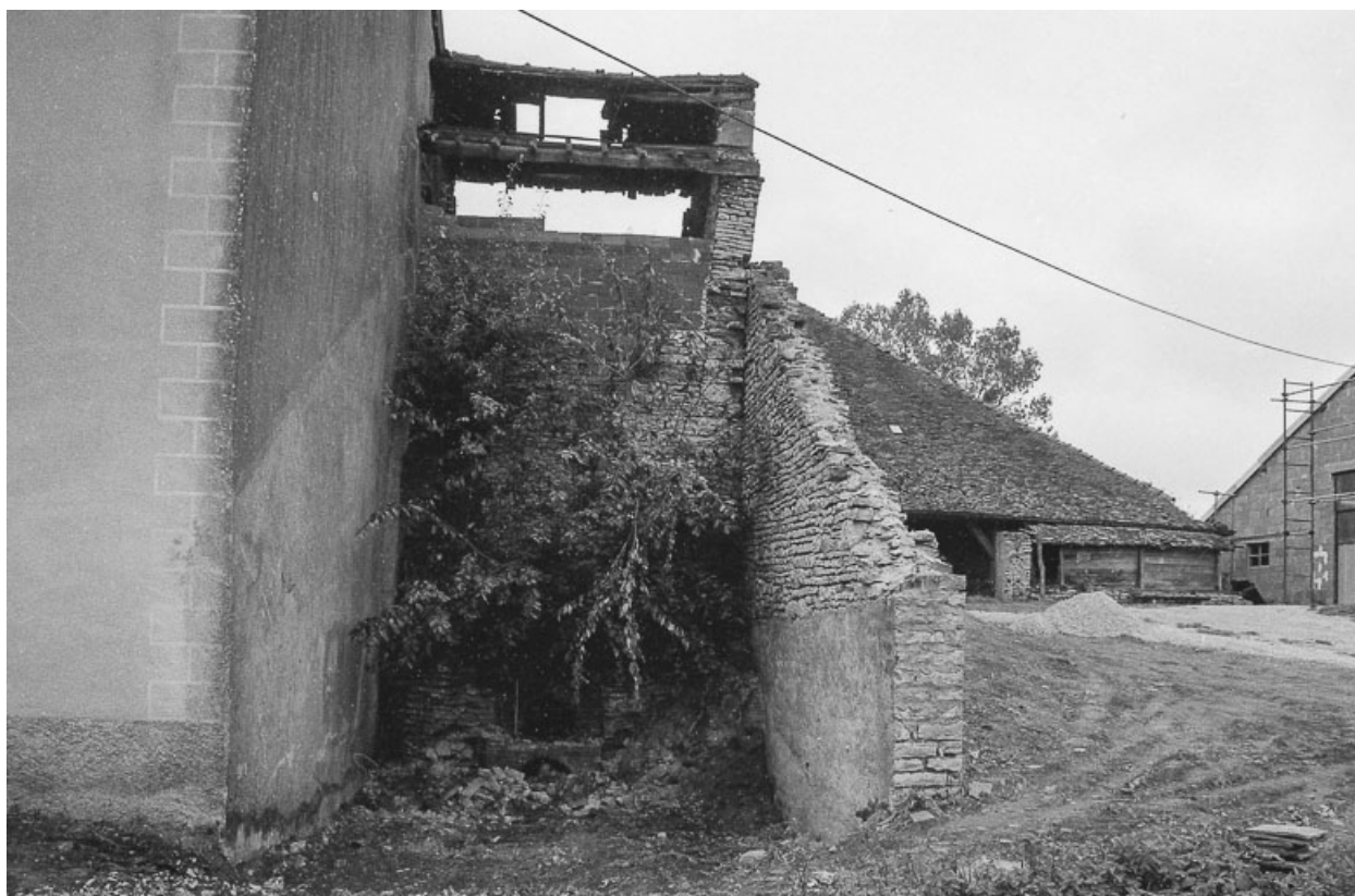
Le four, façade postérieure.
