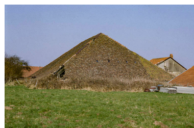
Le toit du séchoir. Phot. Yves Sancey IVR43_19827000490XA
