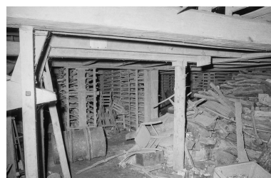
Intérieur du séchoir. Phot. Bernard Lardière IVR43_19797000304Z
