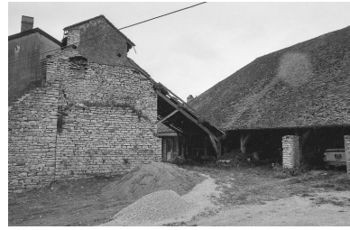
Façade latérale gauche du four. Phot. Bernard Lardière IVR43_19797000301Z
