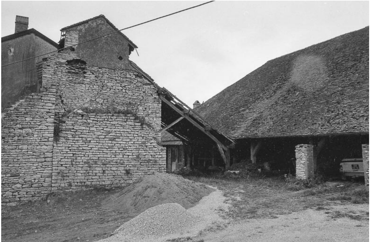
Façade latérale gauche du four.
