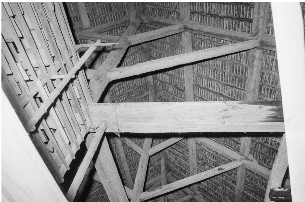
Charpente du séchoir.
