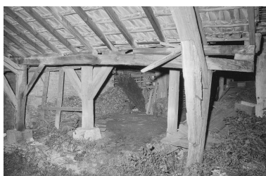
Intérieur du séchoir. Phot. Bernard Lardière IVR43_19797000303Z
