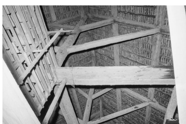
Charpente du séchoir. Phot. Bernard Lardière IVR43_19797000306Z
