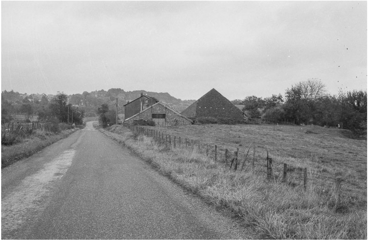
Vue d'ensemble depuis la route.
