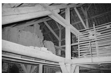
Intérieur du séchoir. Phot. Bernard Lardière IVR43_19797000305Z
