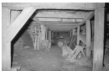
Intérieur du séchoir. Phot. Bernard Lardière IVR43_19797000302Z
