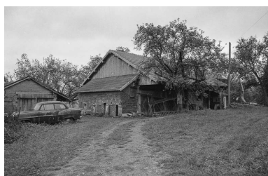
Ferme de la tuilerie. Phot. Bernard Lardière IVR43_19797000299Z
