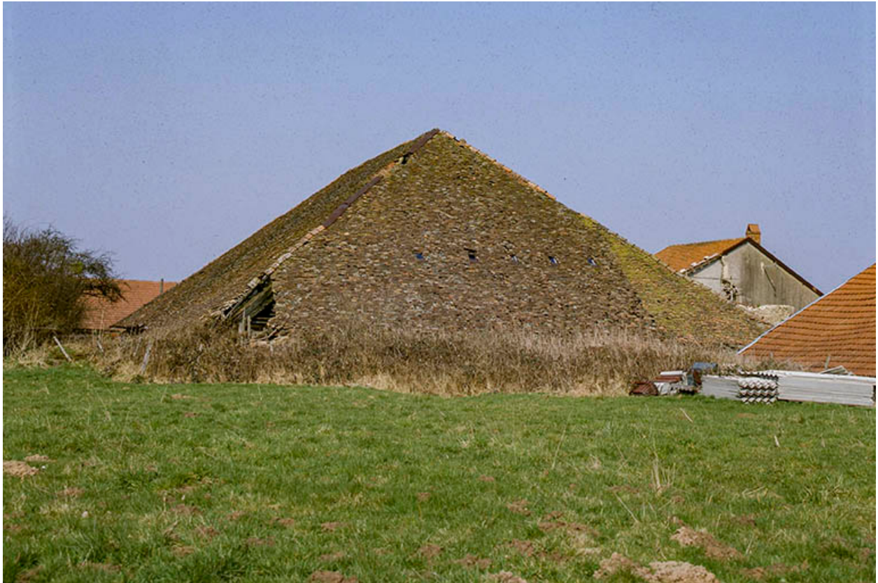
Le toit du séchoir.
