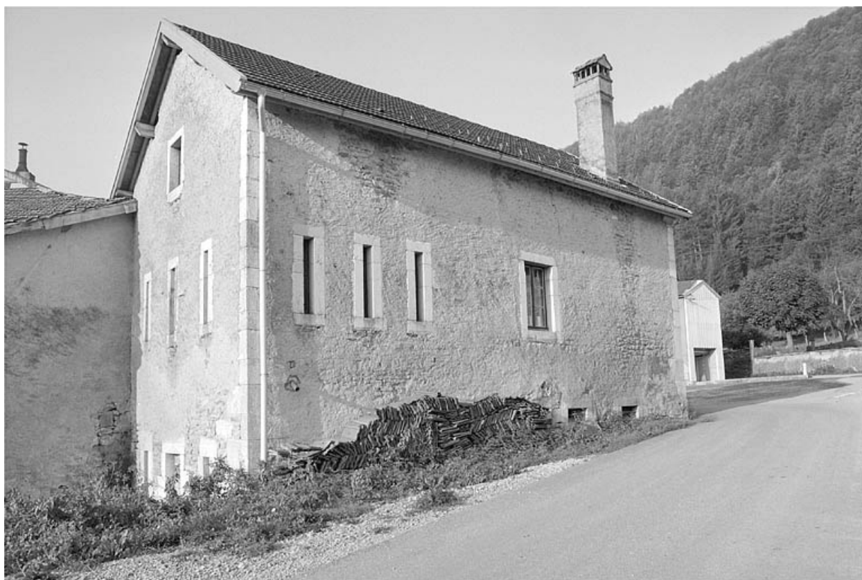
Face gauche et façade postérieure.
