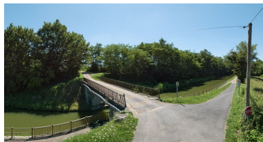
Le pont vu du dessus. Phot. Pierre-Marie Barbe-Richaud IVR26_20137100538NUC4AQ
