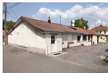
Habitation en rez-de- chaussée. Vue depuis la rue. Phot. Jérôme Mongreville IVR43_20112502287NUC4A
