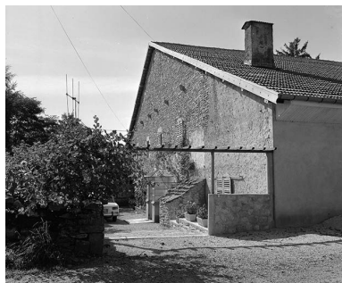
Ferme située route de Flagey. Phot. Yves Sancey IVR43_19802500906X
