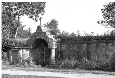
Fontaine située rue du Leichat. Phot. Yves Sancey IVR43_19802500905X
