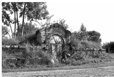
Fontaine située rue du Leichat. Phot. Yves Sancey IVR43_19802500908X
