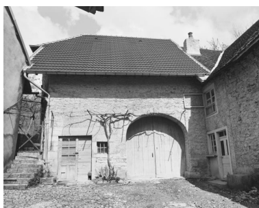
Ferme à Saint-Lothain. Phot. Dominique Dominguez IVR43_19783900147X
