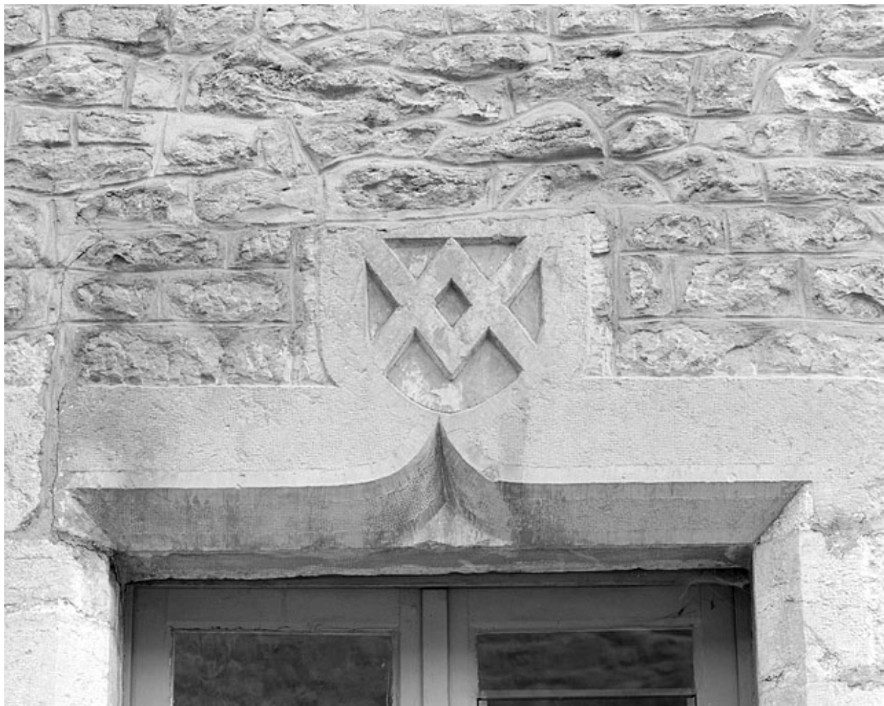
Armoiries au-dessus d'une fenêtre du prieuré.
