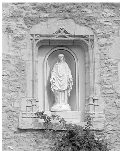
Niche de la face ouest du prieuré. Phot. Jérôme Mongreville IVR43_19963901120X
