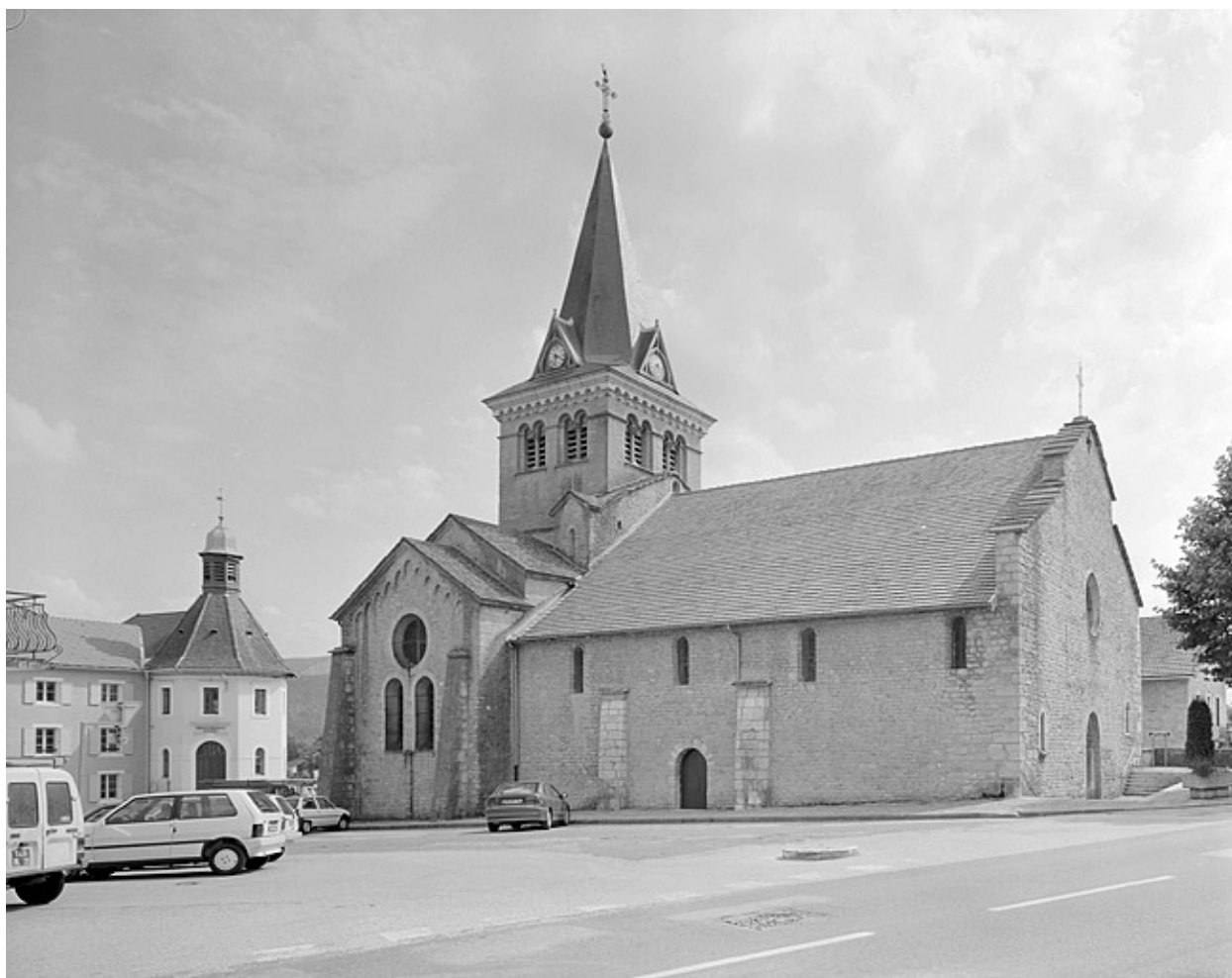
Face latérale nord de l'église.
