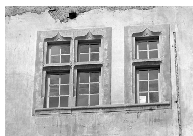
Fenêtres de l'étage de la face est. Phot. Jérôme Mongreville IVR43_19963901119X
