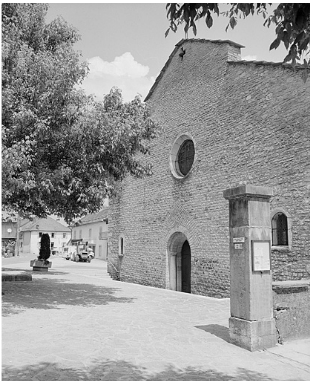
Façade ouest de l'église.
