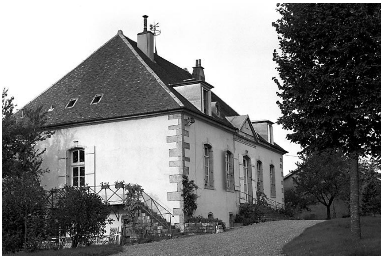
Maison située rue des Granges de Céry.
