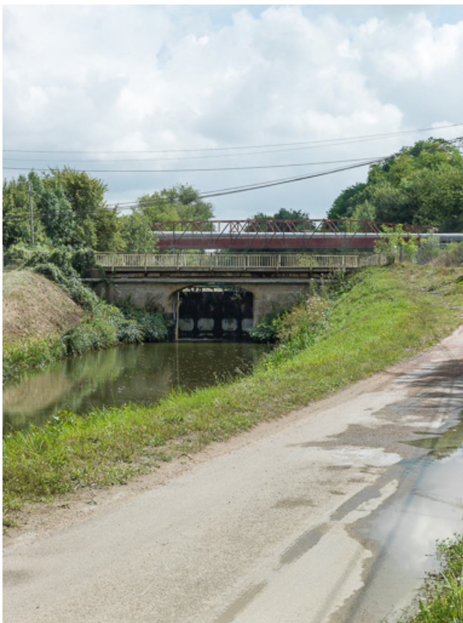
Vue d'ensemble du pont.
