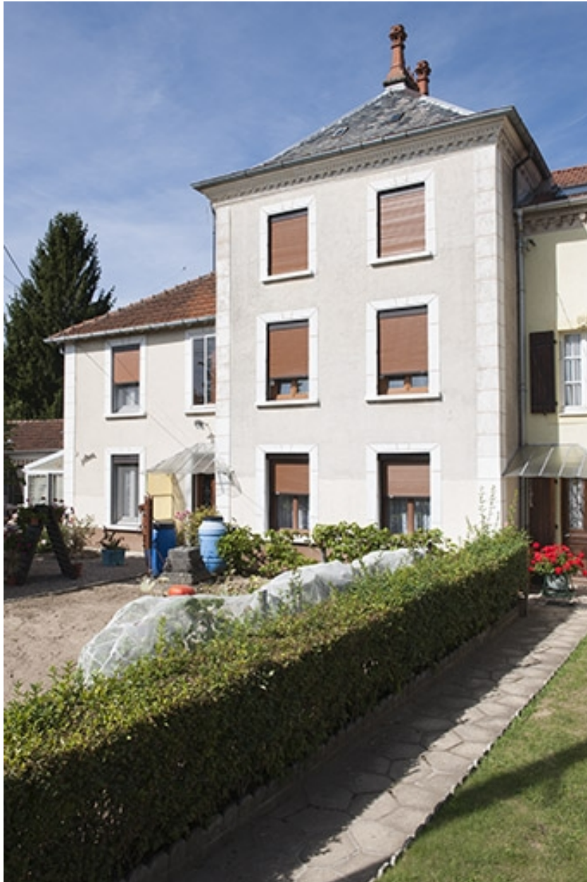
Façade antérieure, partie ouest.
