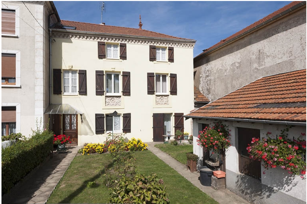
Façade antérieure, partie est.
