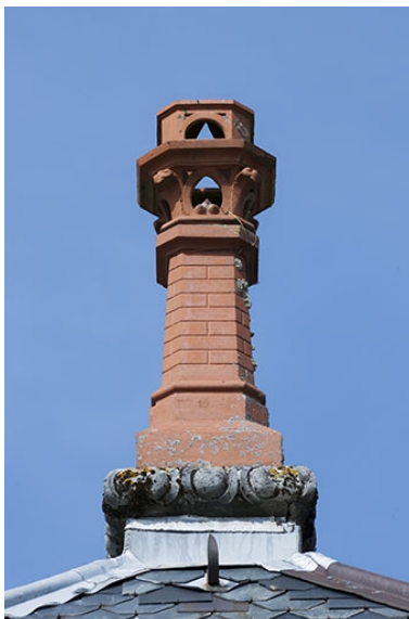
Détail : épi de faîtage. Phot. Jérôme Mongreville IVR43_20137000059NUC4A
