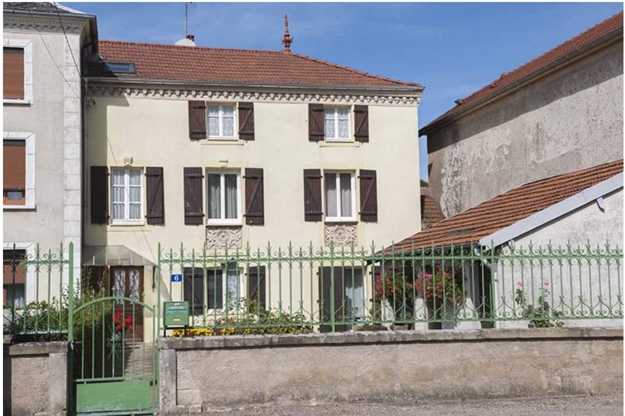
Façade antérieure, partie est.
