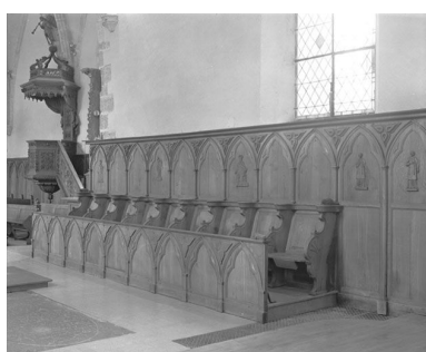
Lambris de demi-revêtement. Phot. Yves Sancey IVR43_19792500550X
