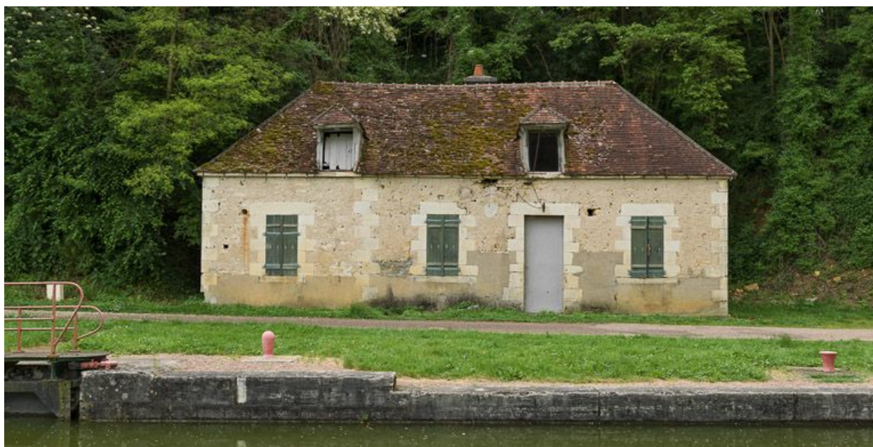
Vue de face de la maison éclusière.
