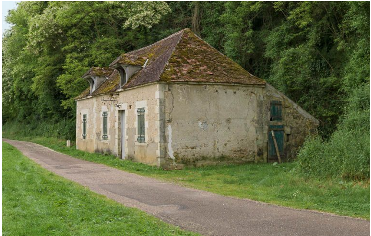
Vue de 3/4 de la maison éclusière.
