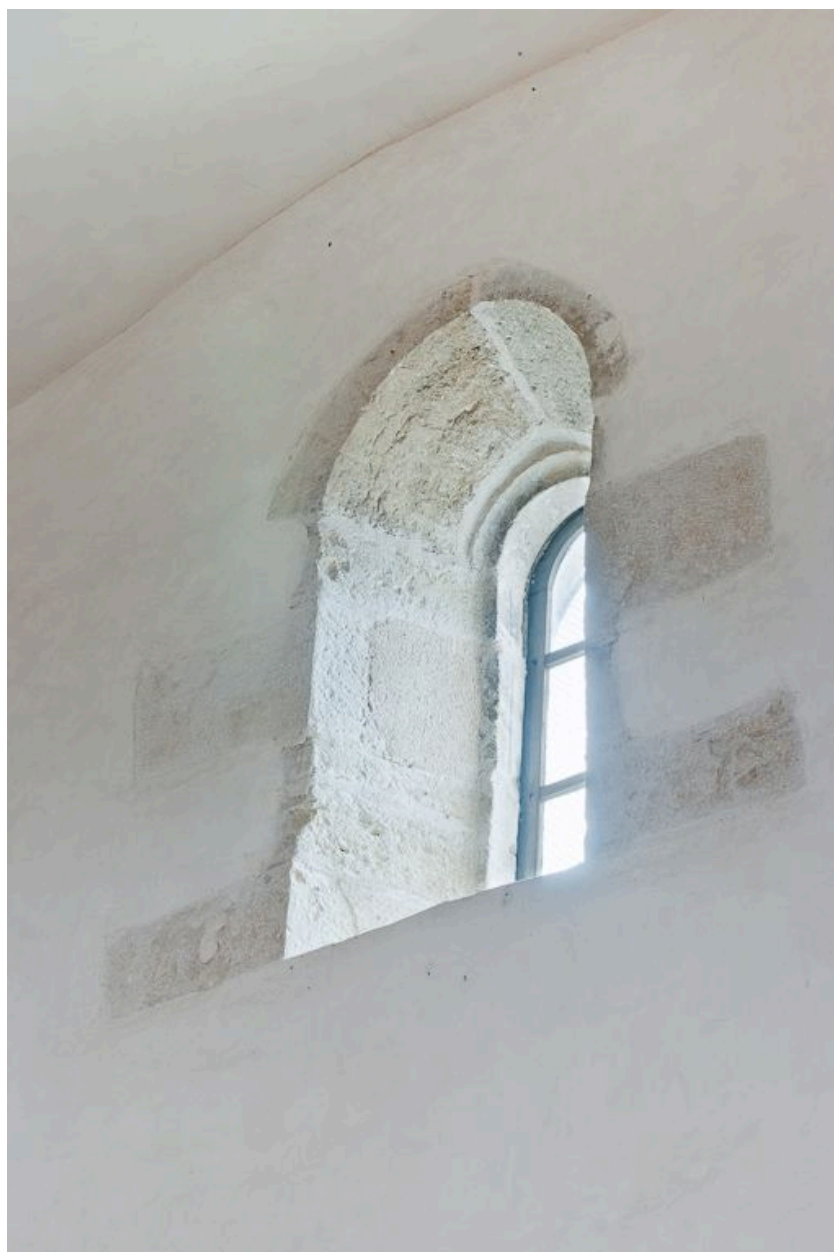
Fenêtre haute droite de la deuxième travée de la nef.
