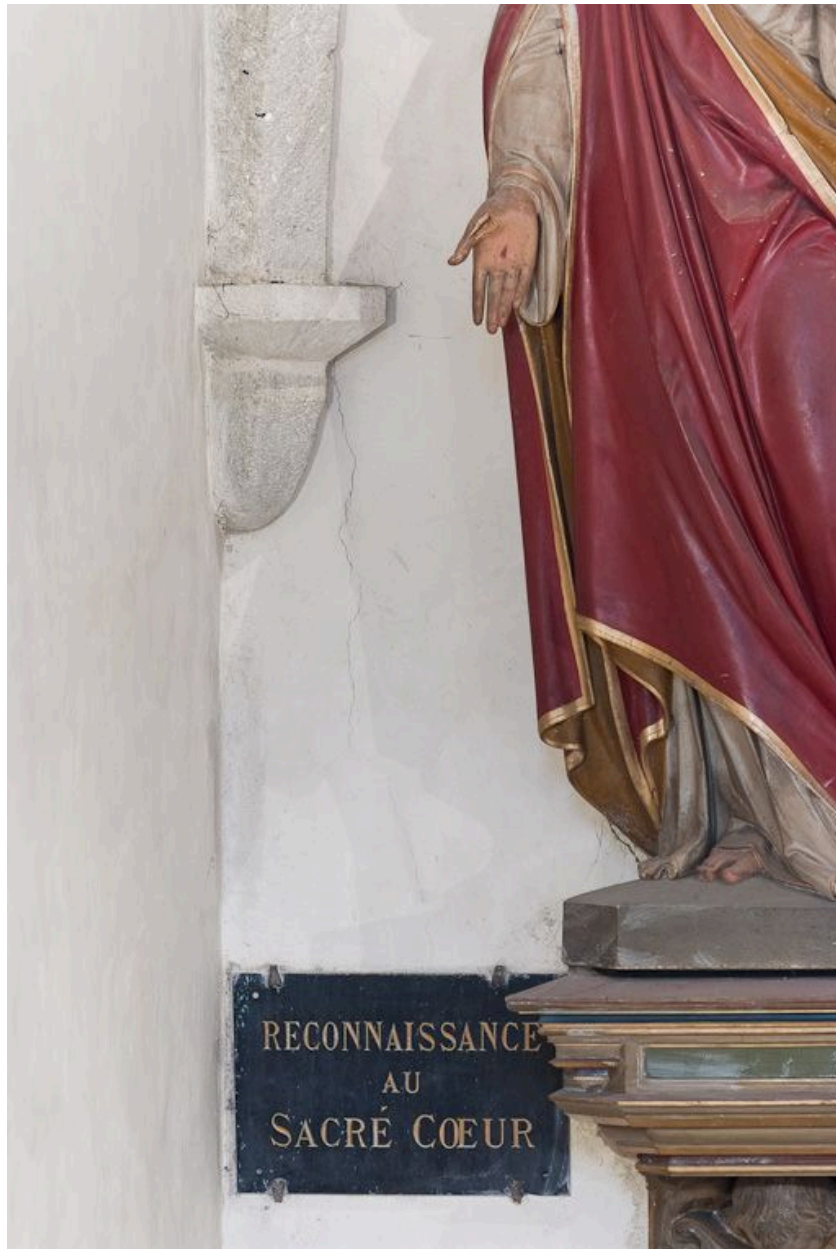
Culot postérieur gauche de la troisième travée de la nef.
