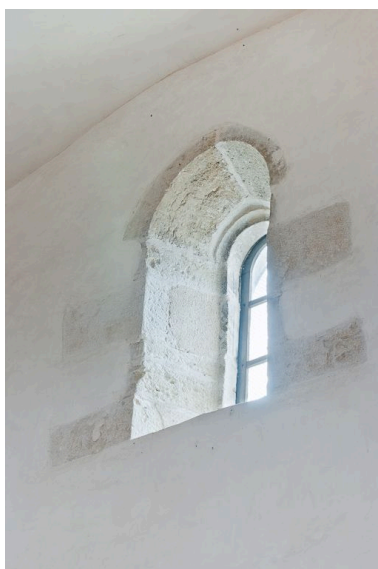
Fenêtre haute droite de la deuxième travée de la nef. Phot. Pierre-Marie Barbe-Richaud IVR26_20112100129NUC2A
