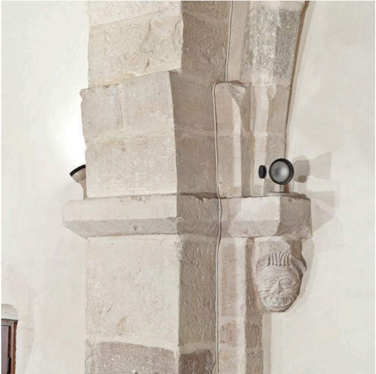
Support et culot antérieur gauche de la troisième travée du bas-côté gauche.
