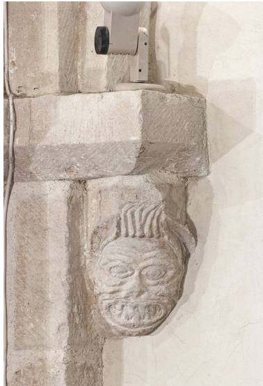
Culot antérieur gauche de la troisième travée du bas-côté gauche. Phot. Pierre-Marie Barbe-Richaud IVR26_20112100134NUC2A
