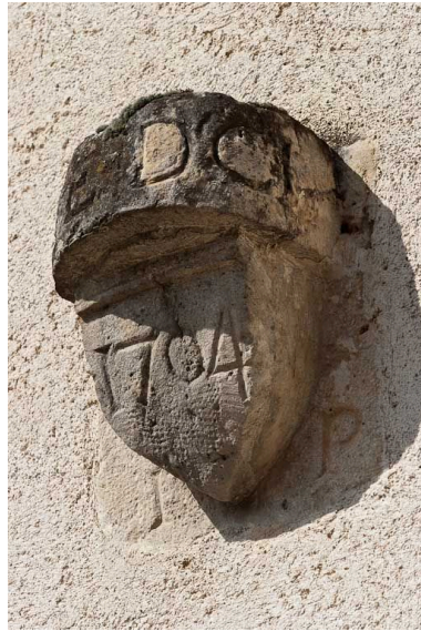
Console extérieure sur le mur de la sacristie. Phot. Pierre-Marie Barbe-Richaud IVR26_20122101072NUC2A
