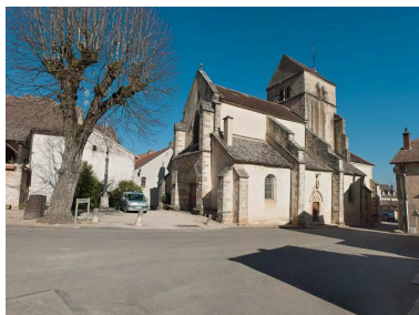
Vue d'ensemble de trois-quarts droit.
