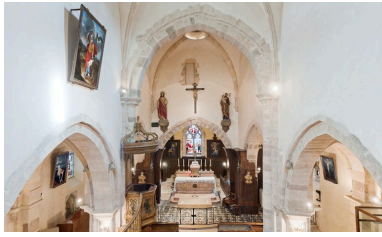
Choeur et bas-côté depuis la tribune. Phot. Pierre-Marie Barbe-Richaud IVR26_20112100116NUC4AQ
