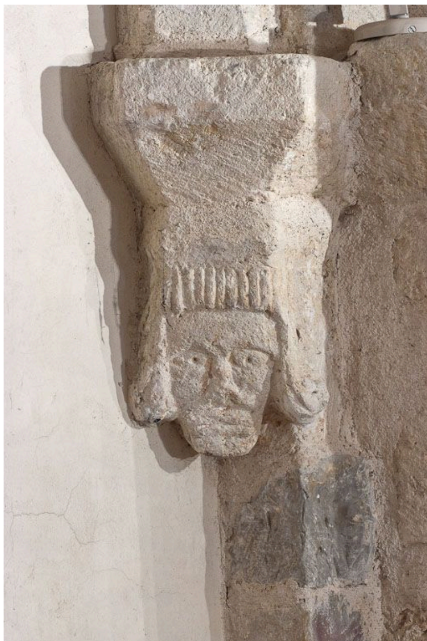
Culot antérieur droit de la troisième travée du bas-côté droit.
