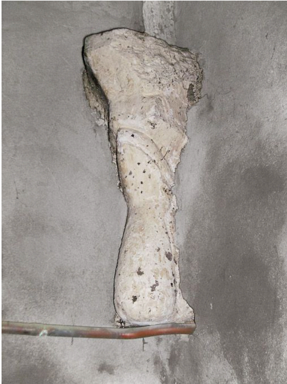
Culot antérieur droit de la première travée du bas-côté droit.
