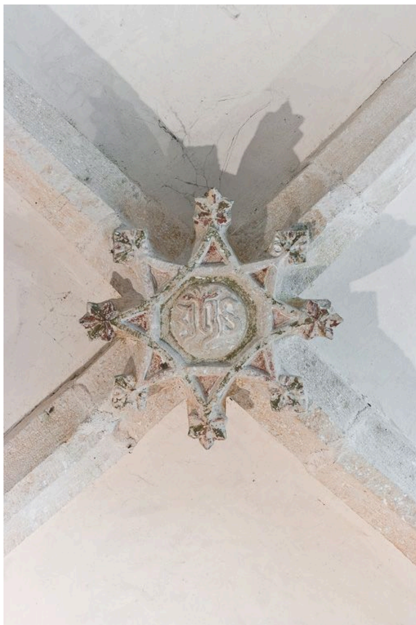
Clef de voûte de la première travée de la nef.
