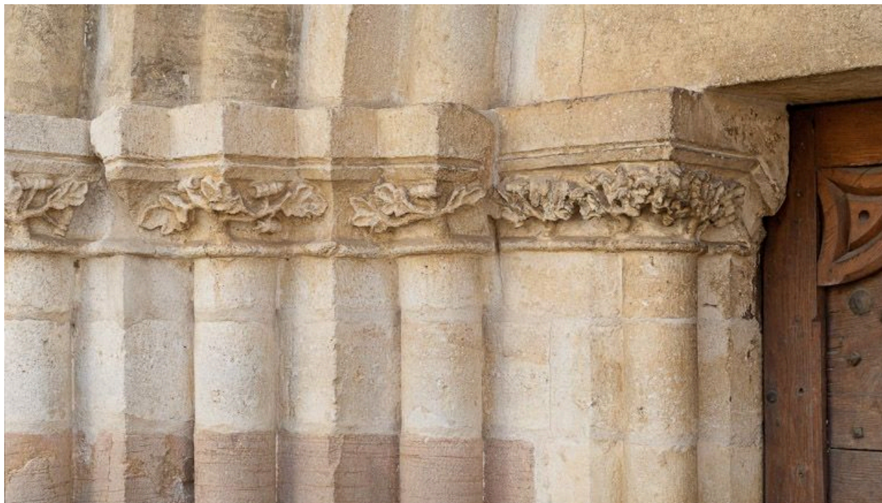
Portail : chapiteaux des colonnettes gauches de l'ébrasement.
