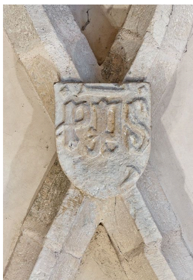
Clef de voûte de la première travée du bas-côté droit. Phot. Pierre-Marie Barbe-Richaud IVR26_20112100139NUC2A
