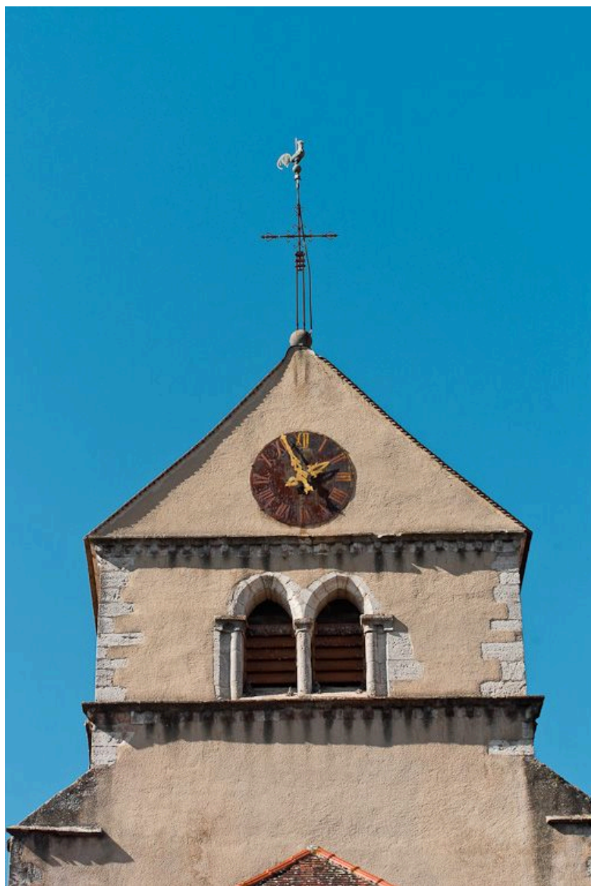
Clocher, élévation postérieure.
