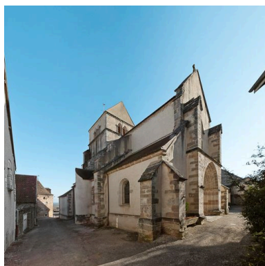
Vue d'ensemble de trois-quarts gauche.
