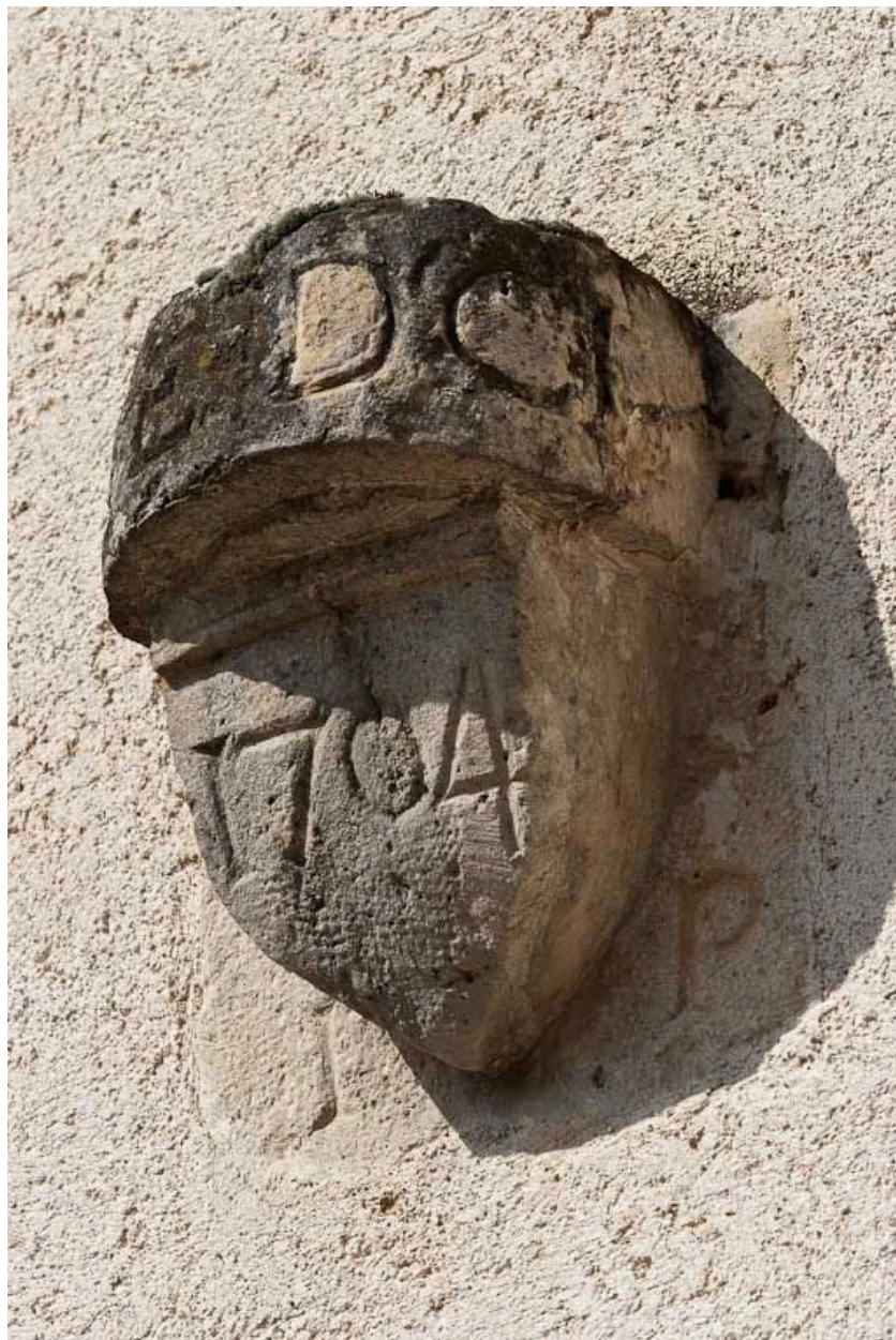
Console extérieure sur le mur de la sacristie.
