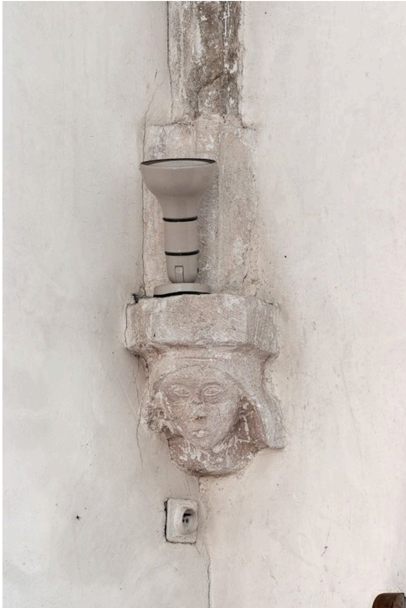
Culot antérieur droit de la première travée de la nef.
