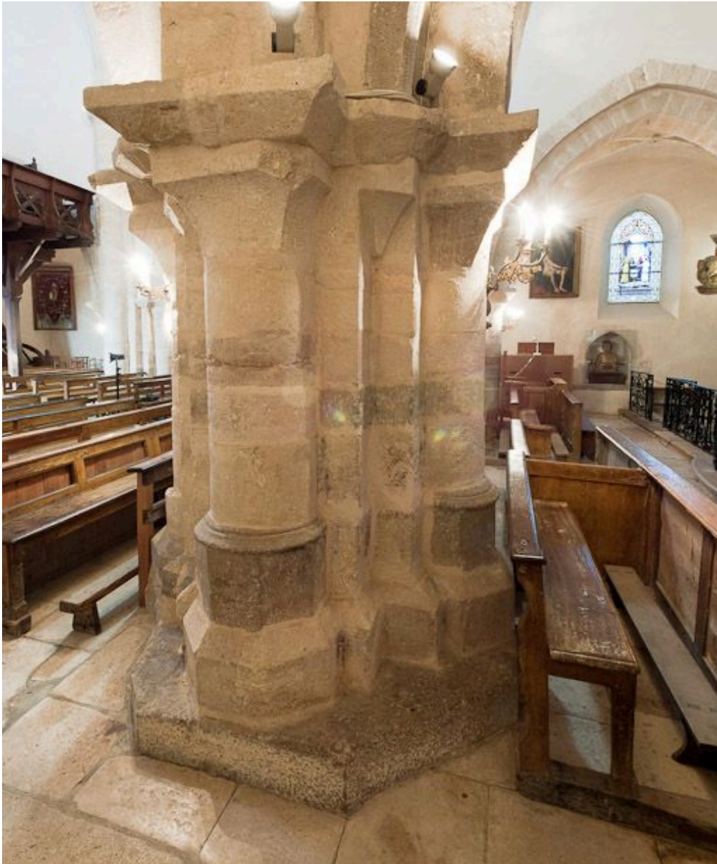
Deuxième pilier entre la nef et le bas-côté droit, vue postérieure.
