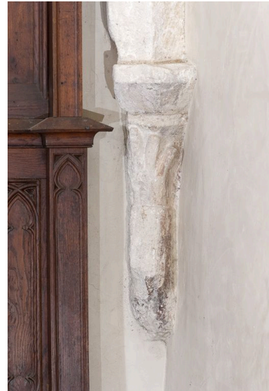
Culot postérieur droit de la troisième travée du bas-côté droit. Phot. Pierre-Marie Barbe-Richaud IVR26_20112100145NUC2A
