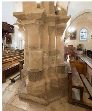
Deuxième pilier entre la nef et le bas-côté droit, vue postérieure. Phot. Pierre-Marie Barbe-Richaud IVR26_20112100121NUC4AQ
