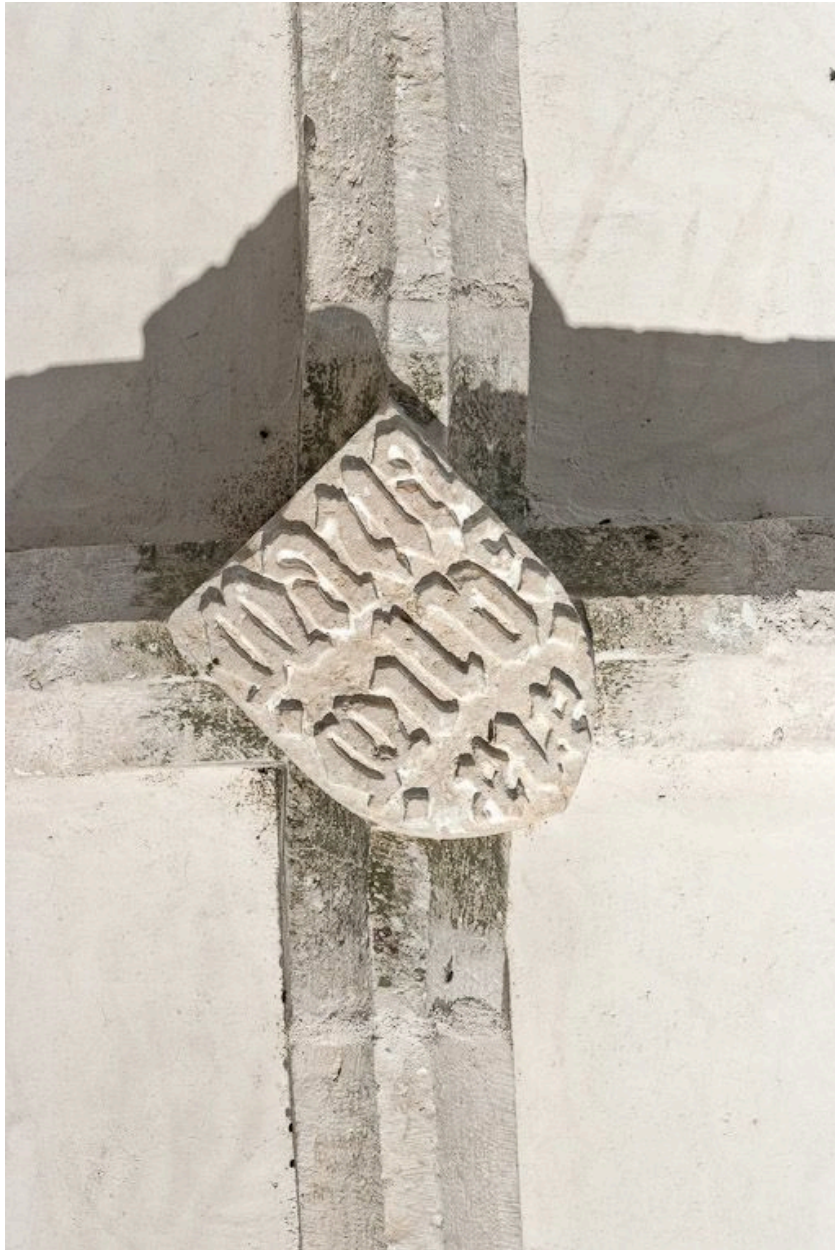
Clef de voûte de la deuxième travée de la nef.
