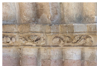
Portail : chapiteaux des colonnettes droites de l'ébrasement. Phot. Pierre-Marie Barbe-Richaud IVR26_20122101068NUC4AQ
