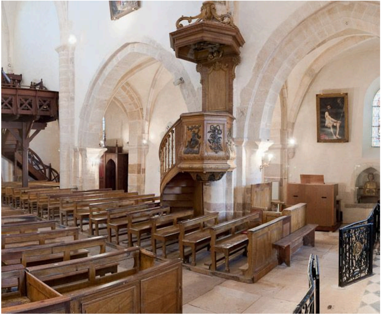
Nef et bas-côté gauche depuis le chœur.
