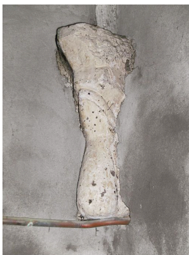
Culot antérieur droit de la première travée du bas-côté droit. Phot. Brigitte Fromaget IVR26_20112100138NUC2A
