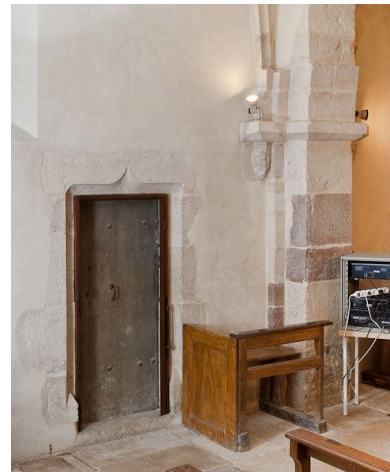
Porte de la tourelle d'escalier. Phot. Pierre-Marie Barbe-Richaud IVR26_20112100120NUC2AQ
