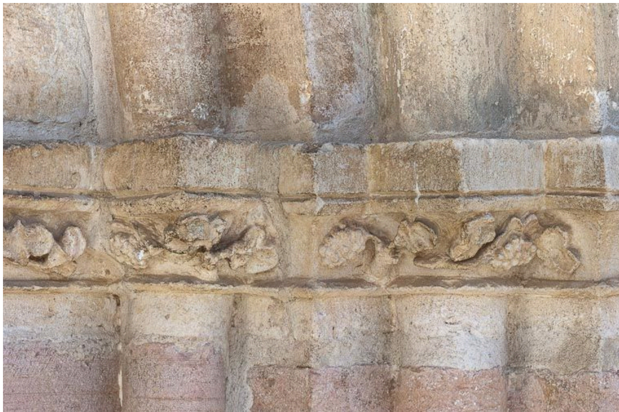
Portail : chapiteaux des colonnettes droites de l'ébrasement.
