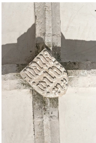
Clef de voûte de la deuxième travée de la nef. Phot. Pierre-Marie Barbe-Richaud IVR26_20112100128NUC2A
