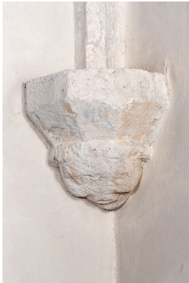
Culot antérieur gauche de la première travée du bas-côté gauche. Phot. Pierre-Marie Barbe-Richaud IVR26_20112100132NUC2A
