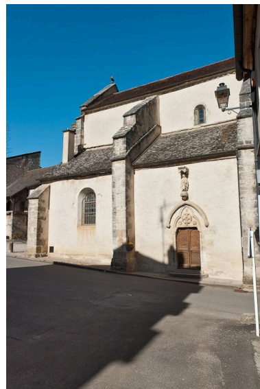
Elévation droite de la nef.
