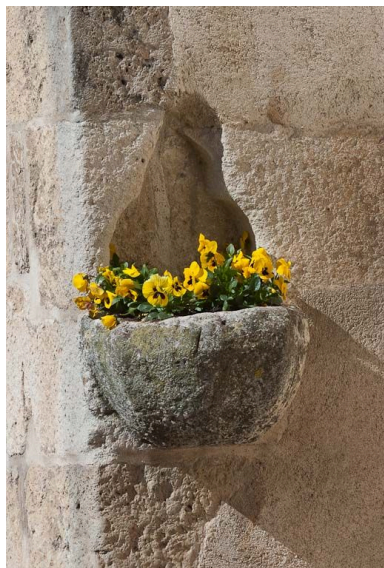
Bénitier à gauche de la porte latérale. Phot. Pierre-Marie Barbe-Richaud IVR26_20122101062NUC2A
