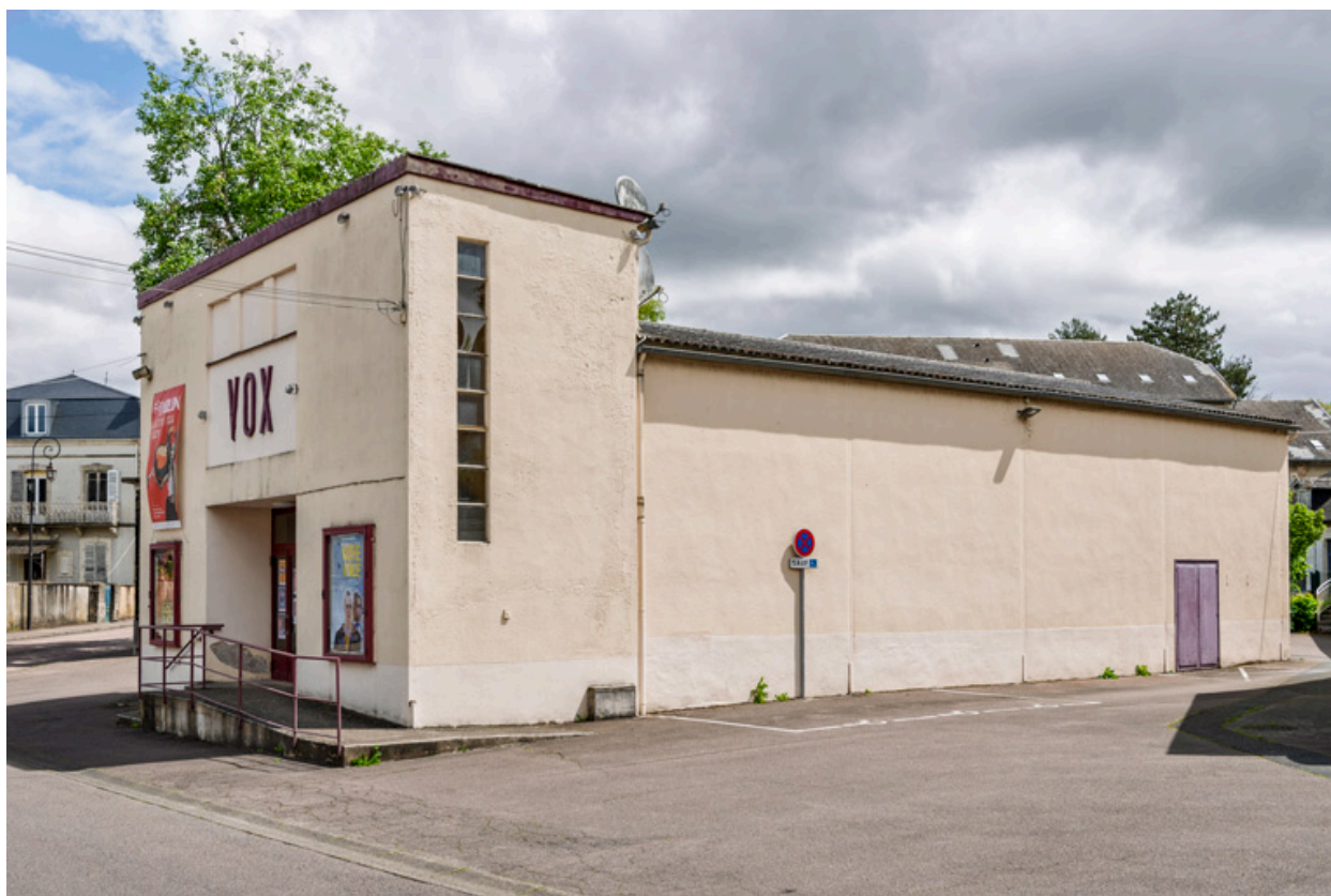
Vue d'ensemble depuis le sud (façades antérieure et latérale droite).
