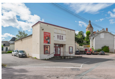
Vue d'ensemble depuis le nord (façades antérieure et latérale gauche). Phot. Pierre-Marie Barbe-Richaud IVR26_20245800237NUC4A
