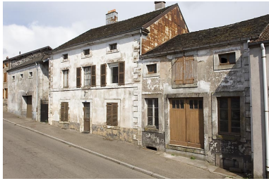
Vue d'ensemble depuis la rue de Plombières. Phot. Jérôme Mongreville IVR43_20077000140NUCA
