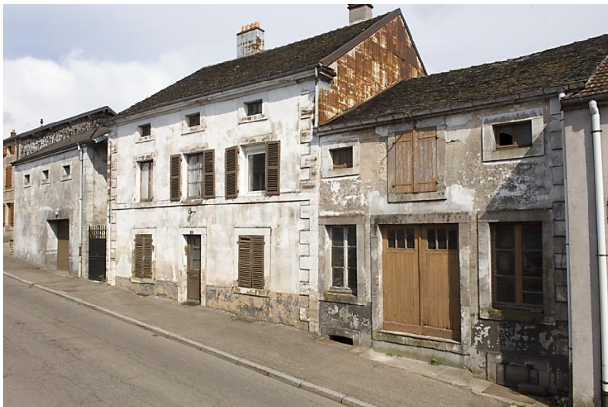
Vue d'ensemble depuis la rue de Plombières.
