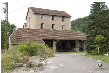
Vue depuis l'est. Phot. Jérôme Mongreville IVR43_20077000334NUCA
