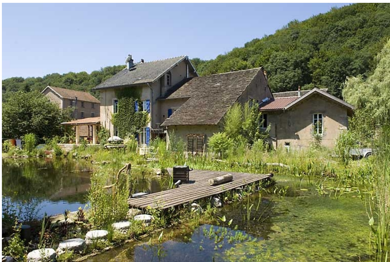
Le moulin et les logements depuis l'est.
