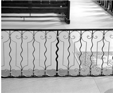
Détail. Phot. Yves Sancey IVR43_19963900796X
