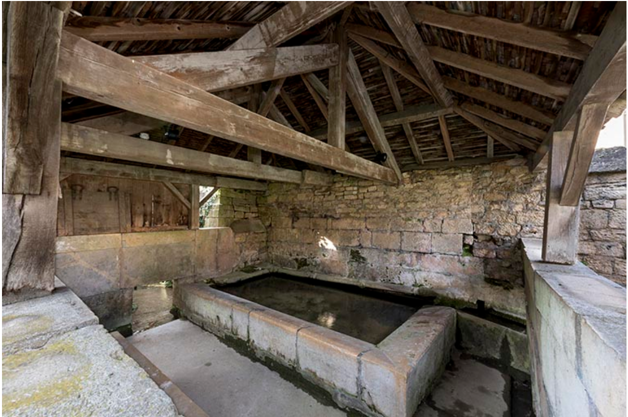
Fontaine-lavoir, 1 rue du Pâquis : intérieur du lavoir.
