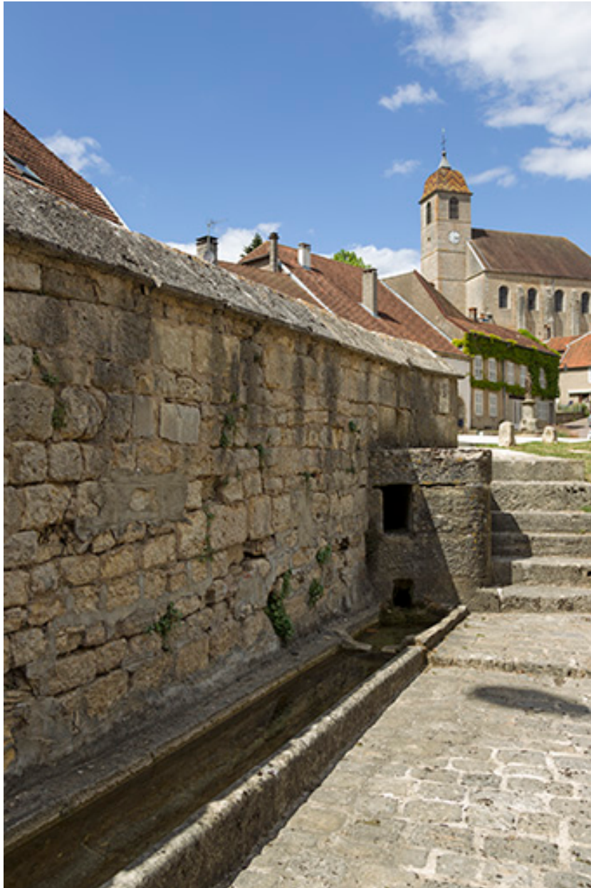
Fontaine-lavoir, 1 rue du Pâquis : l'arrivée d'eau.
