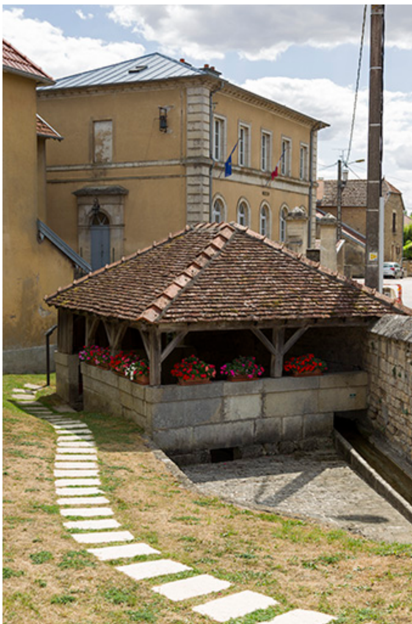
Fontaine-lavoir, 1 rue du Pâquis.
