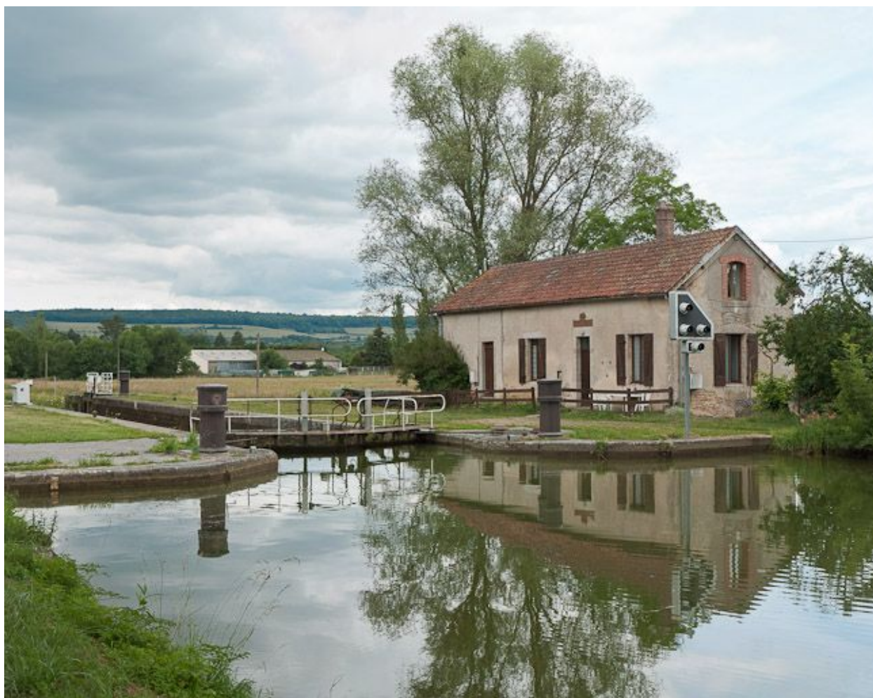
Vue d'ensemble du site d'écluse.
