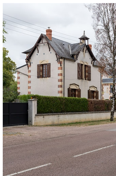
Vue de trois quarts, depuis l'avenue. Phot. Pierre-Marie Barbe-Richaud IVR26_20205800464NUC4A
