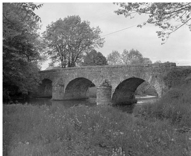
Face amont, vue de trois quarts Phot. Yves Sancey IVR43_19813900074X
