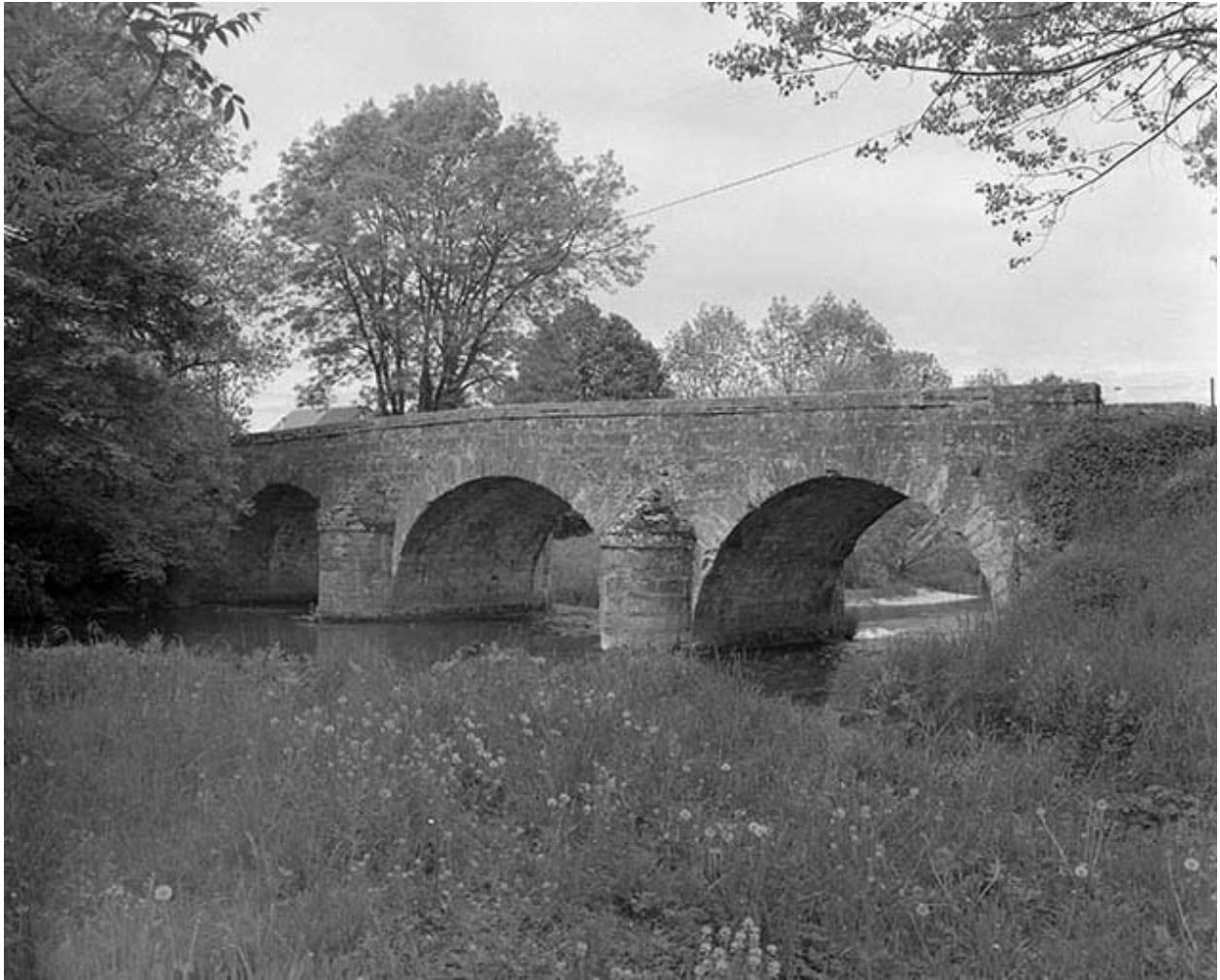
Face amont, vue de trois quarts
