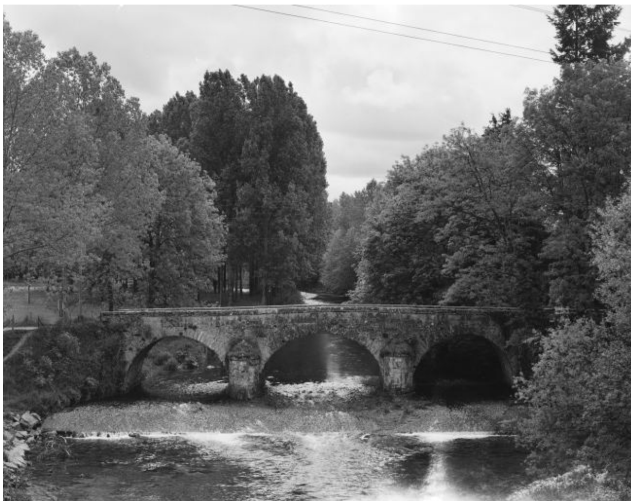
Face aval, vue de face.
