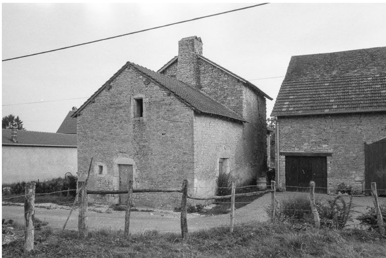
Maison située 7 rue de Vauvenise à Bonnevent.
