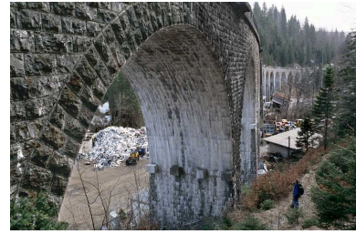
Une arche côté Andelot-en- Montagne, vue en enfilade.
