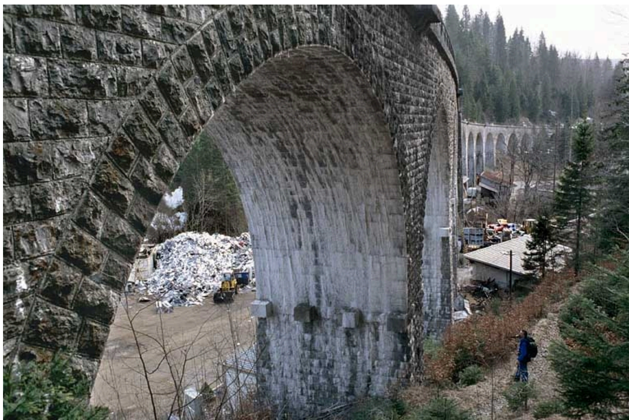
Une arche côté Andelot-en-Montagne, vue en enfilade.
