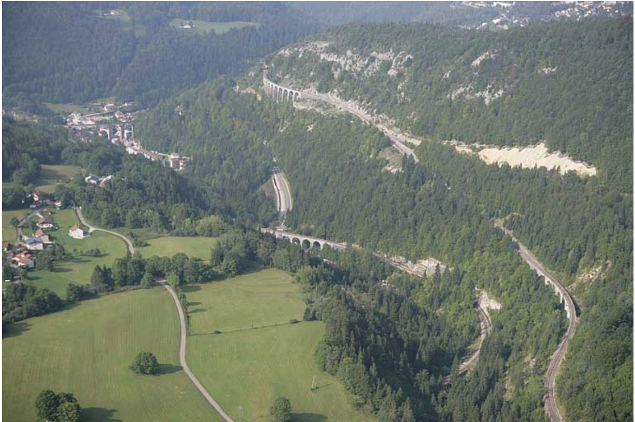
Vue aérienne du viaduc et des autres ouvrages d'art entre Morbier et Morez, depuis le nord-est.
