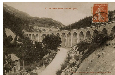
Le grand Viaduc de Morez [le viaduc de l'Evalude, vu du sud], entre 1900 et 1912. Porte la date : 10 novembre 1912 Phot. , Phot. E. Mandrillon IVR43_20073900009NUCA
