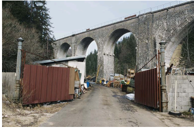
Elévation occidentale (extrémité côté Andelot-en- Montagne), depuis l'ouest.
