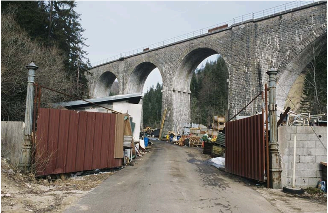
Elévation occidentale (extrémité côté Andelot-en-Montagne), depuis l'ouest.
