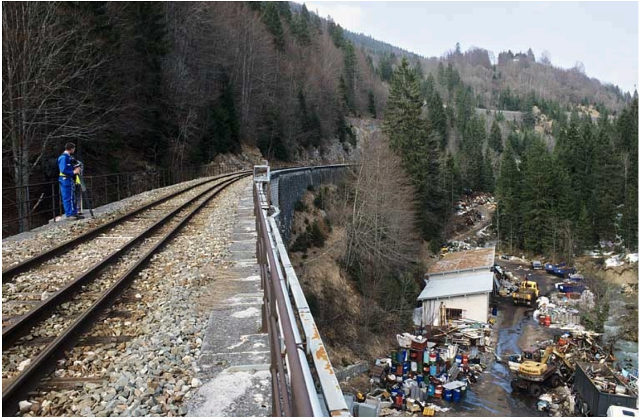
Extrémité côté Andelot-en-Montagne, vue depuis la voie au sud (côté La Cluse).
