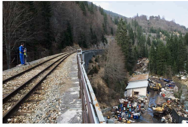
Extrémité côté Andelot- en-Montagne, vue depuis la voie au sud (côté La Cluse).
