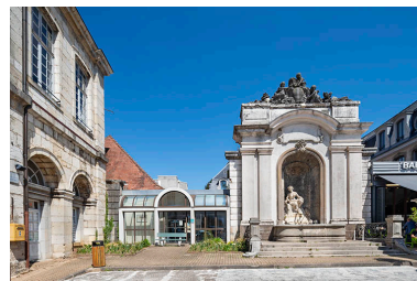
Vue d'ensemble, avec l'entrée de l'ancien établissement thermal à gauche. Phot. Jérôme Mongreville IVR43_20223900449NUC4A
