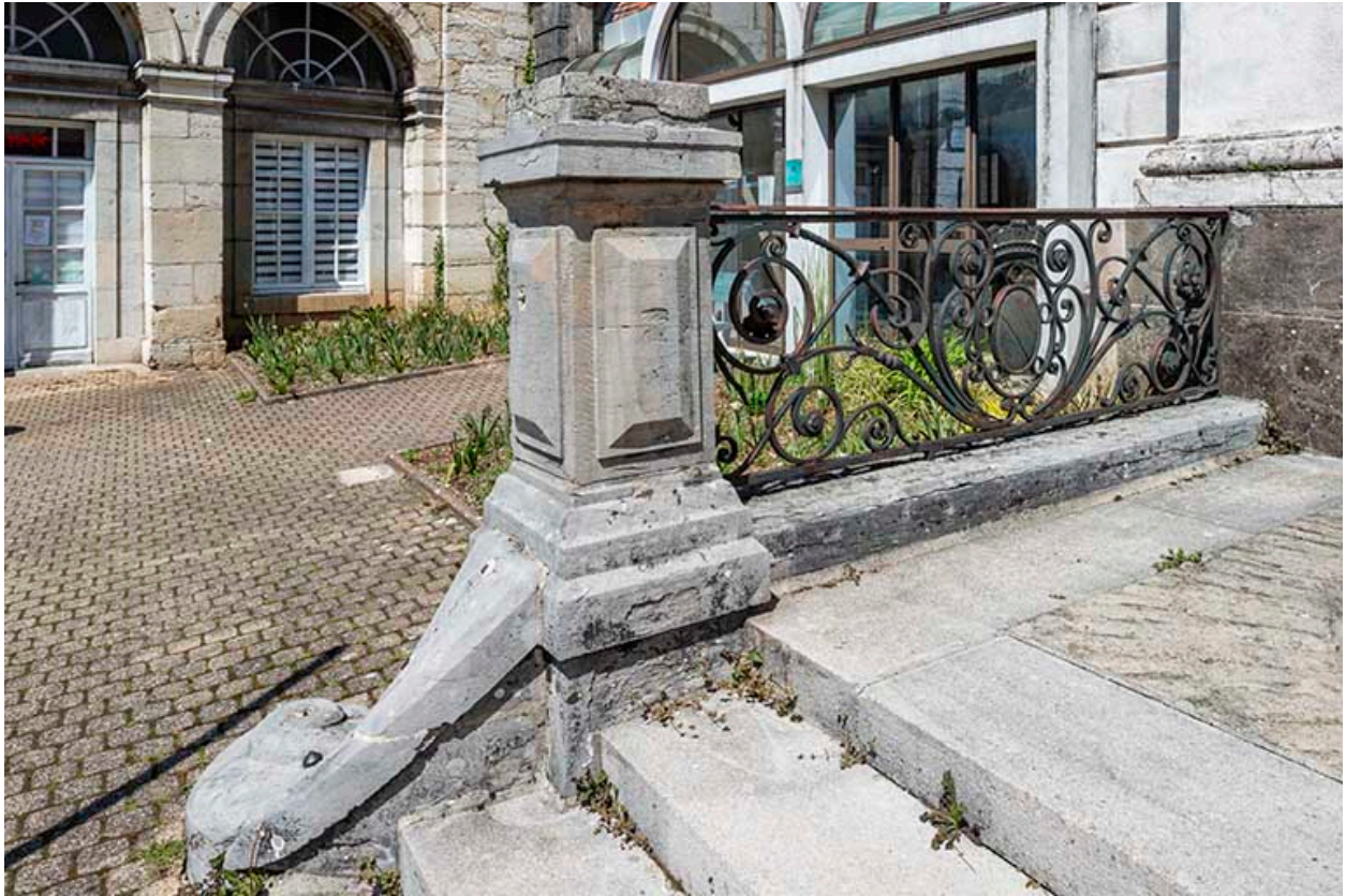
Garde-corps de la partie gauche.
