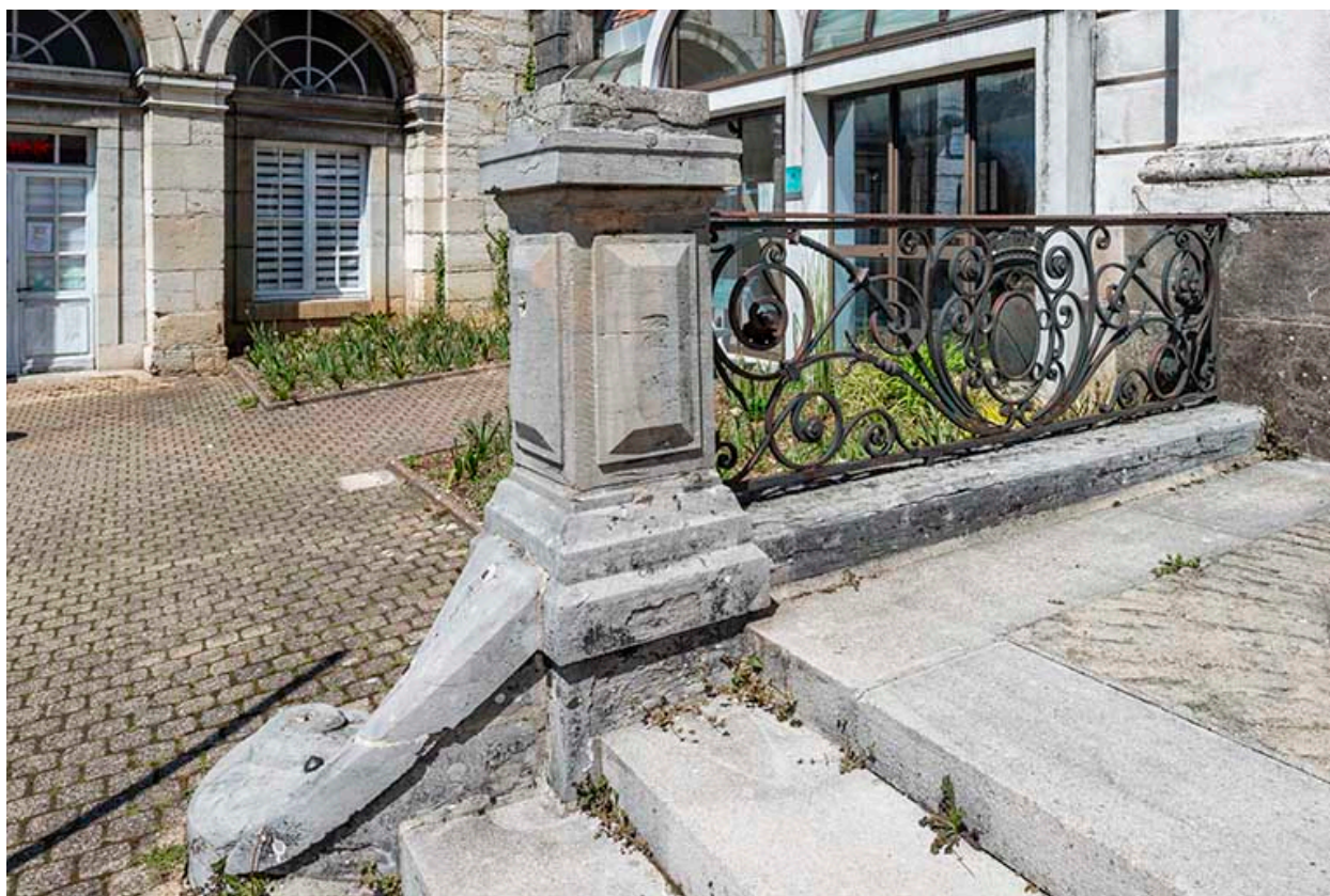
Garde-corps de la partie gauche.
