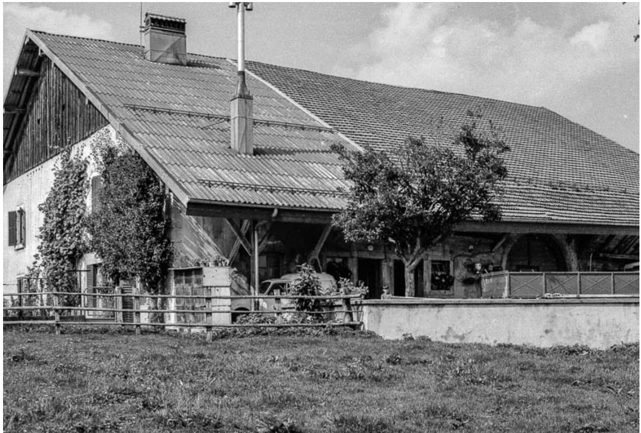
Pignon habitation et gouttereau droit.
