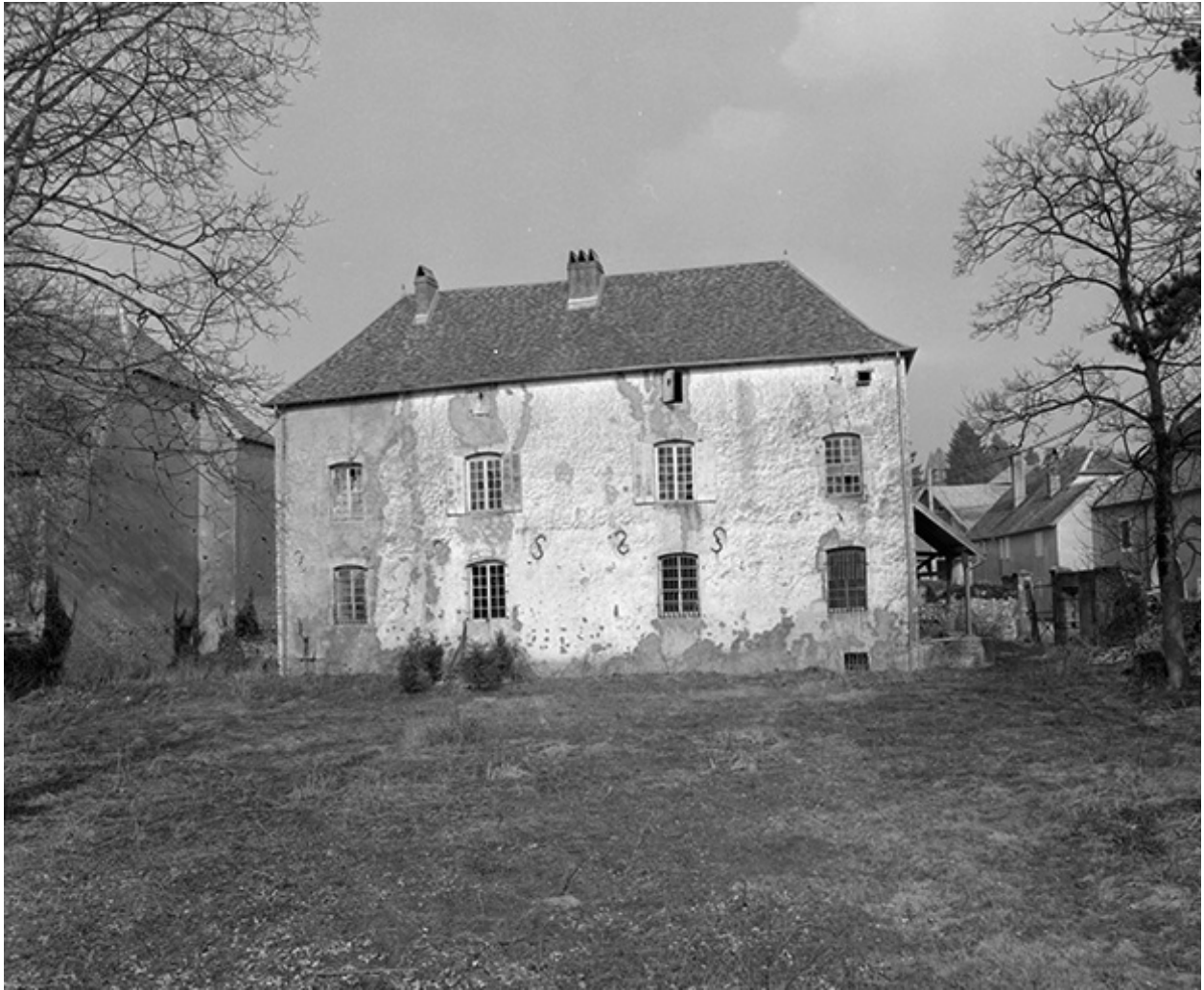
Façade sur le parc.
