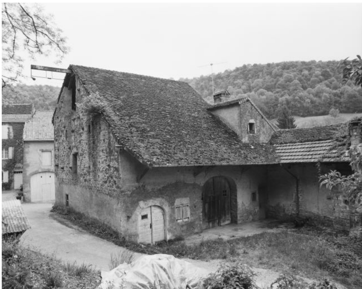
Ferme située rue du Fond de Vau : façades antérieure et latérale gauche.
