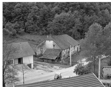
Ferme située rue Saint- Vincent : vue d'ensemble.
