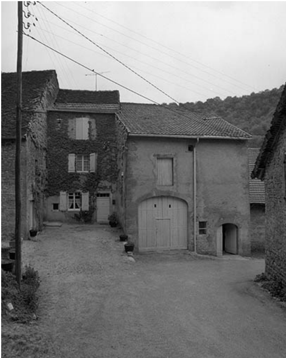
Ferme située Fond de Vau : façade antérieure.
