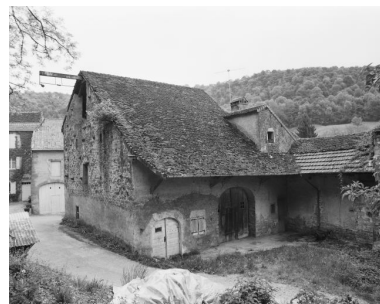
Ferme située rue du Fond de Vau : façades antérieure et latérale gauche. Phot. Yves Sancey IVR43_19813900106X
