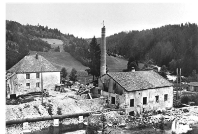
La centrale hydroélectrique de Bellefontaine. Phot. Jérôme Mongreville IVR43_19973900938X
