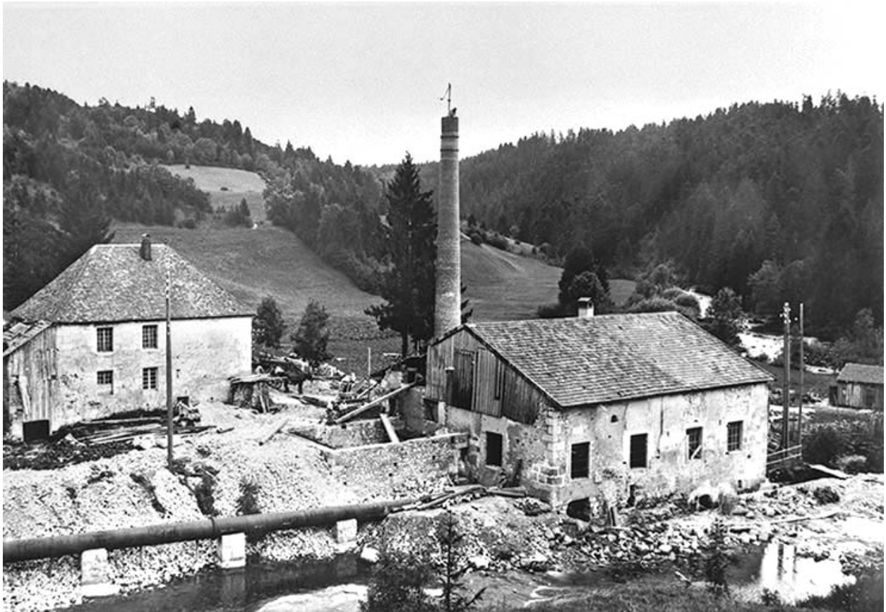
La centrale hydroélectrique de Bellefontaine.
