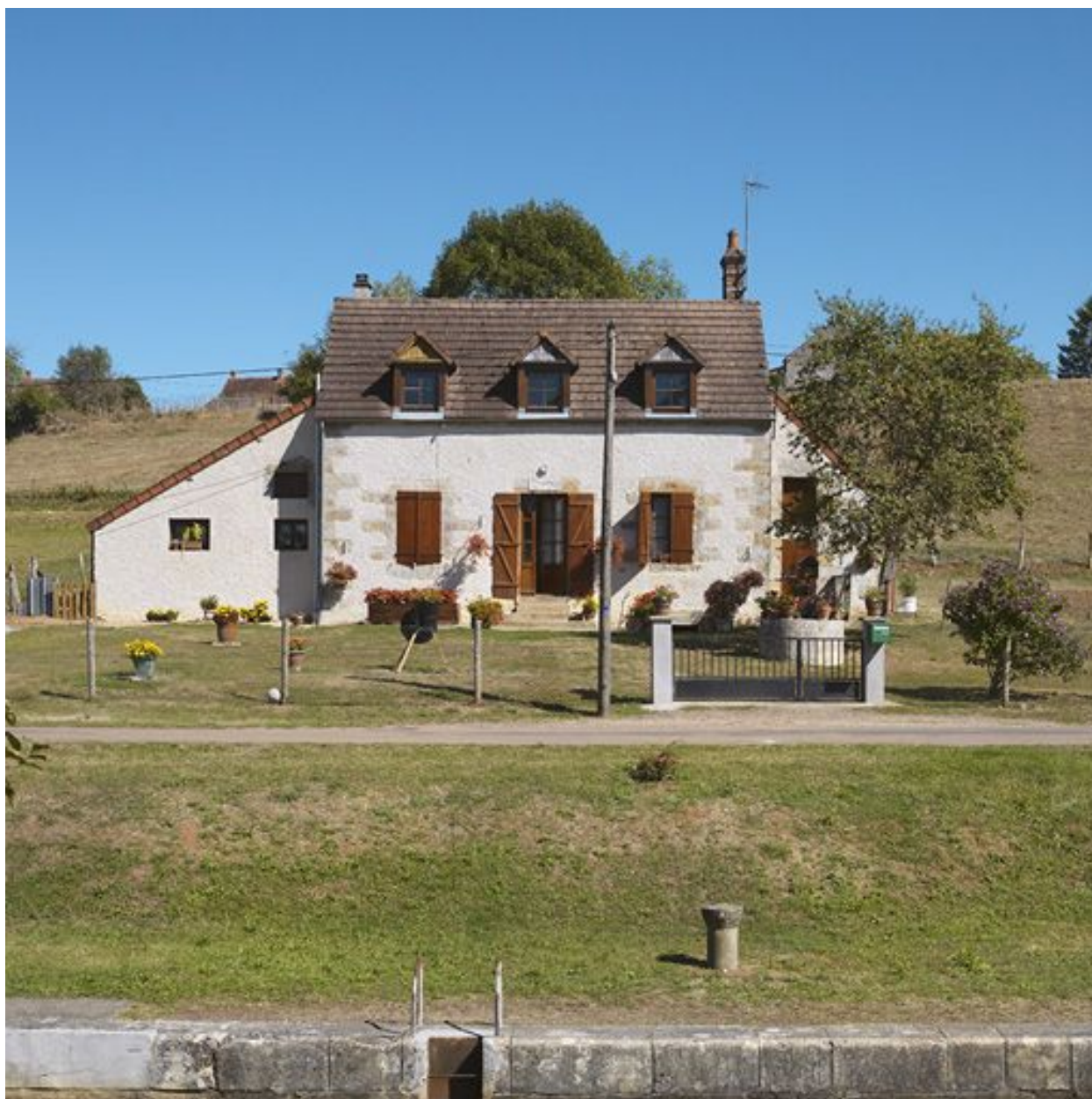
La maison éclusière, de face.
