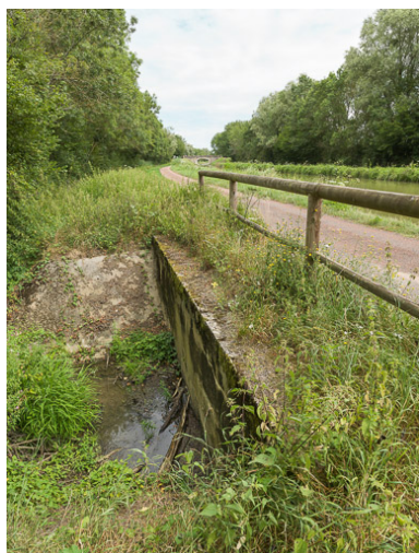
Vue de l'aqueduc.
