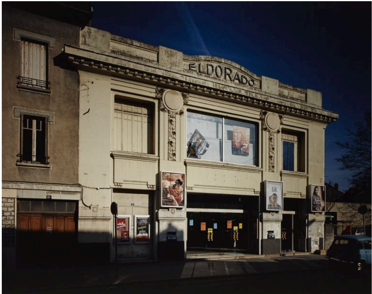
Vue d'ensemble de la façade en 1994.
