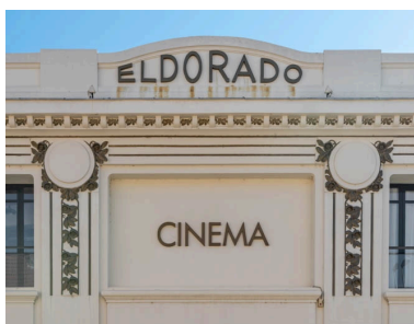
Façade antérieure : décor de la partie haute et couronnement. Phot. Pierre-Marie Barbe-Richaud IVR26_20212100113NUC4A
