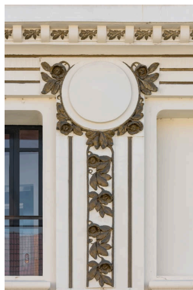
Façade antérieure : décor végétal. Phot. Pierre-Marie Barbe-Richaud IVR26_20212100111NUC4A
