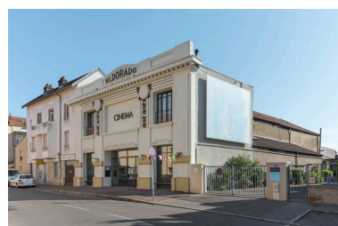
Vue d'ensemble, de trois quarts droite. Phot. Pierre-Marie Barbe-Richaud IVR26_20212100109NUC4A
