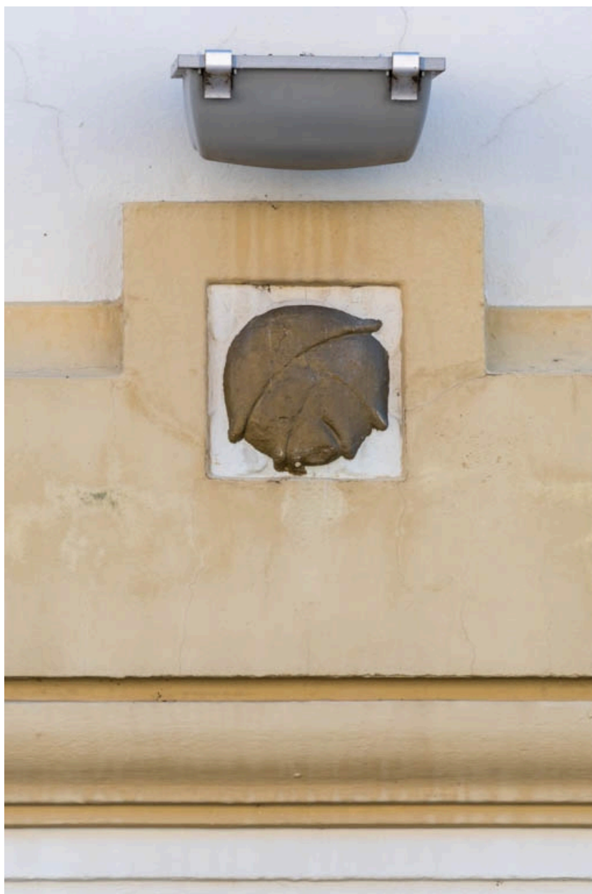
Façade antérieure : détail du décor.
