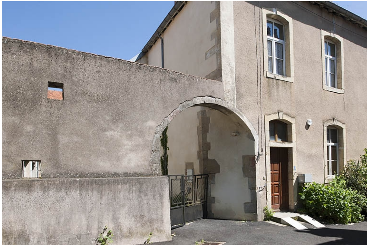
Façade latérale gauche.
