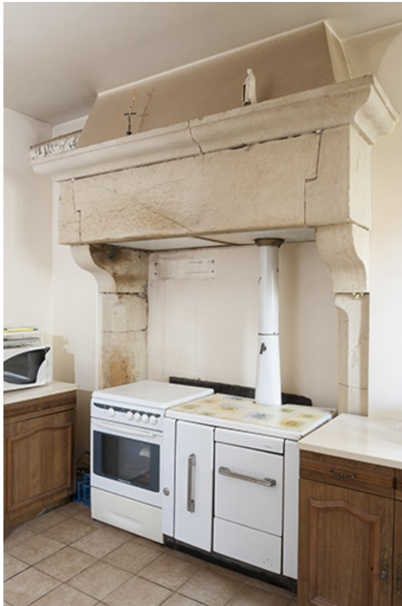
Cuisine : vue générale de la cheminée.
