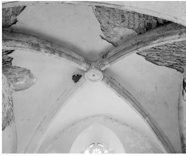
Intérieur : voûte de la chapelle latérale droite.
