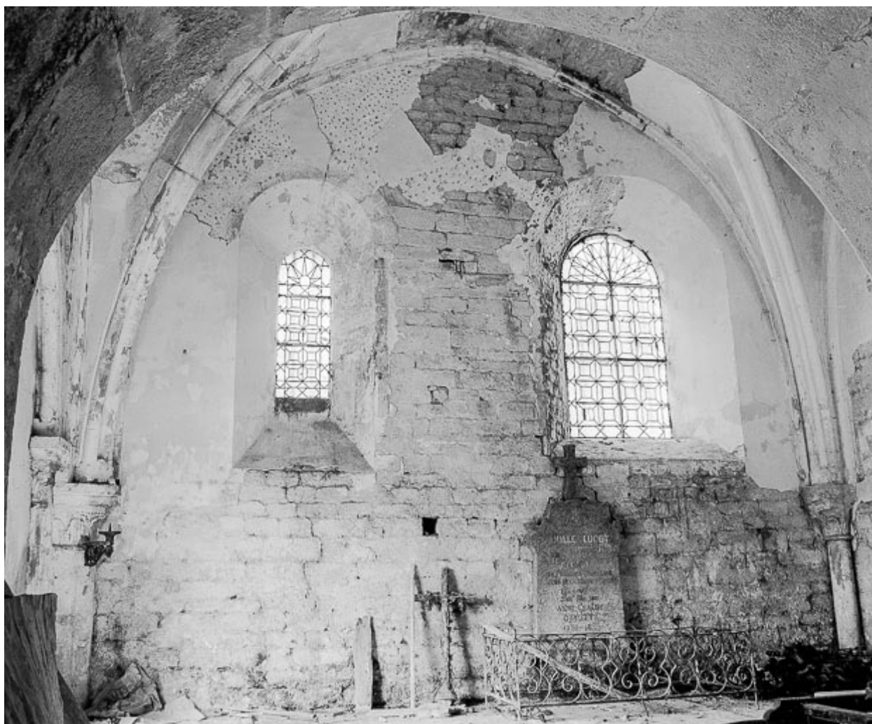
Intérieur : mur latéral gauche.
