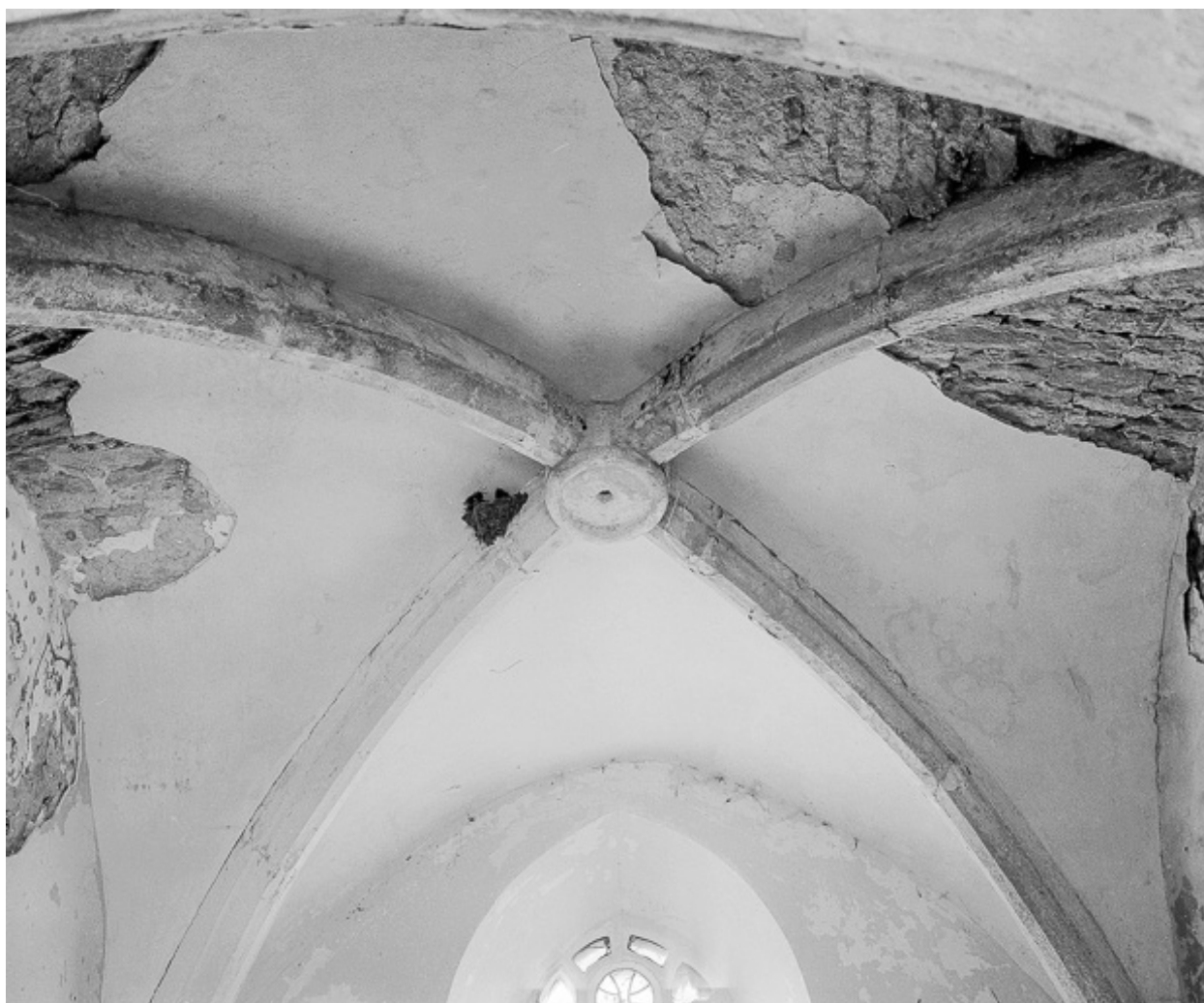
Intérieur : voûte de la chapelle latérale droite.
