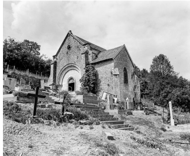
Façade antérieure et chapelle droite. Phot. Yves Sancey IVR43_19777000106X
