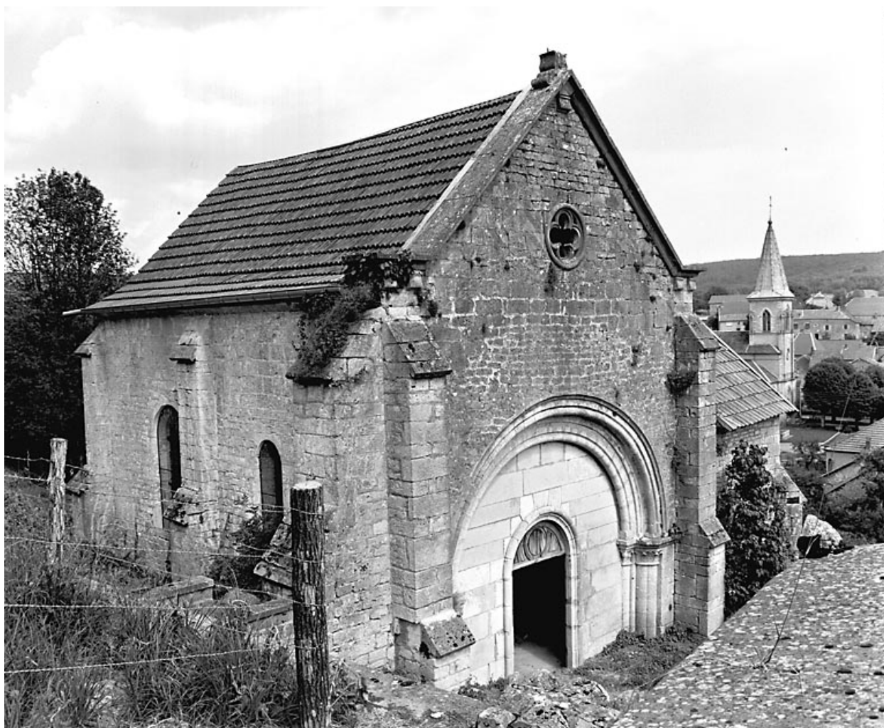
Façades antérieure et latérale gauche.
