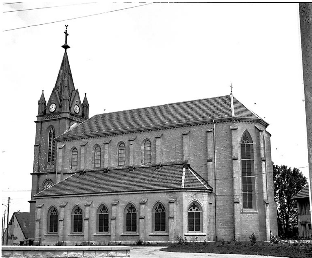
Façade latérale sud.
