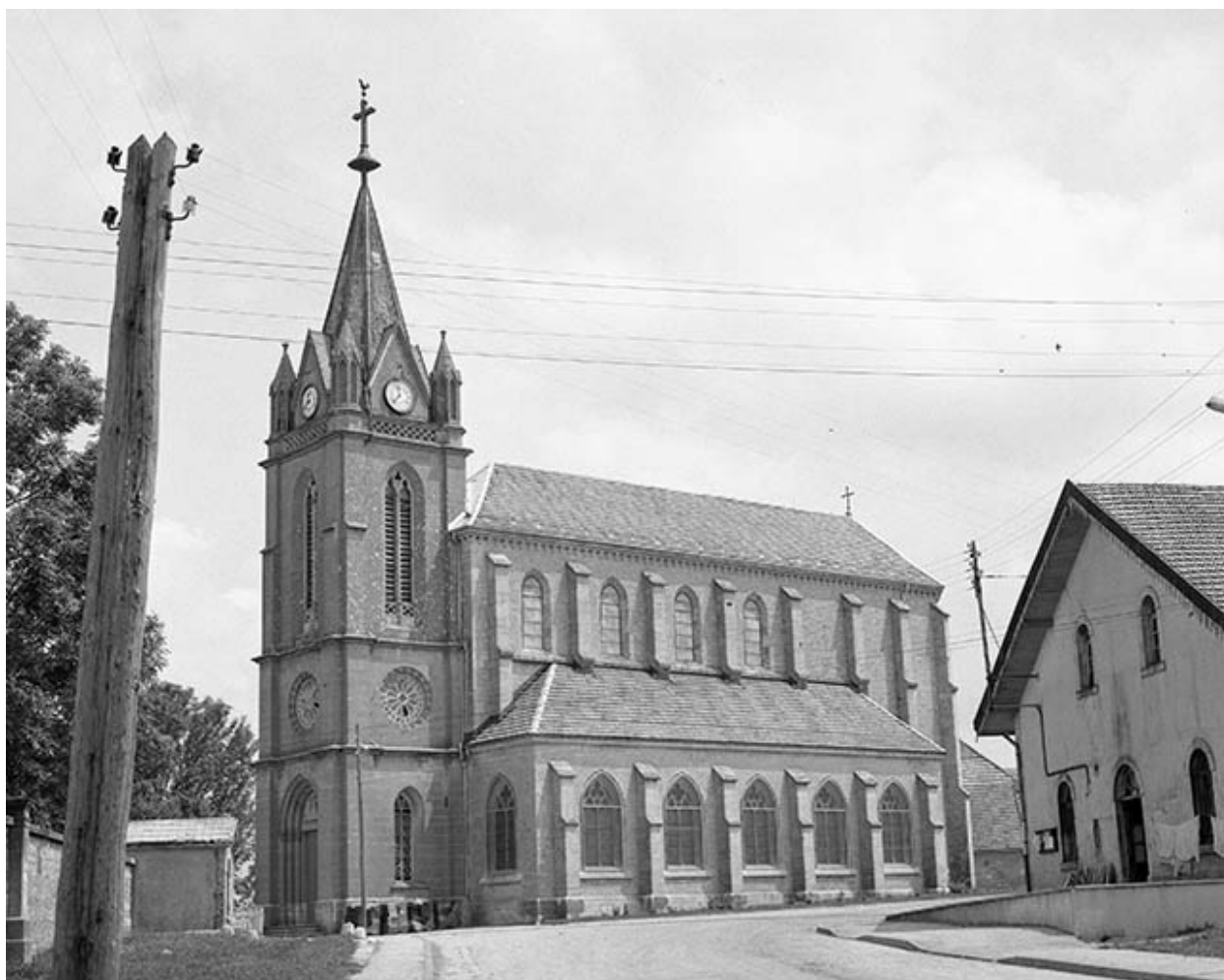
Tour-clocher et façade latérale sud.
