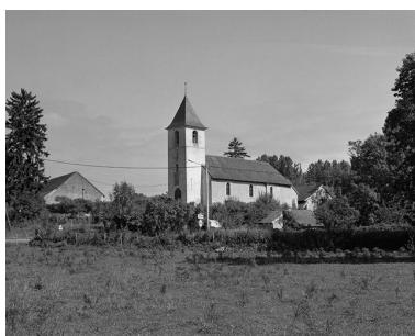
Façades antérieure et latérale droite. Phot. Yves Sancey IVR43_19843900115X
