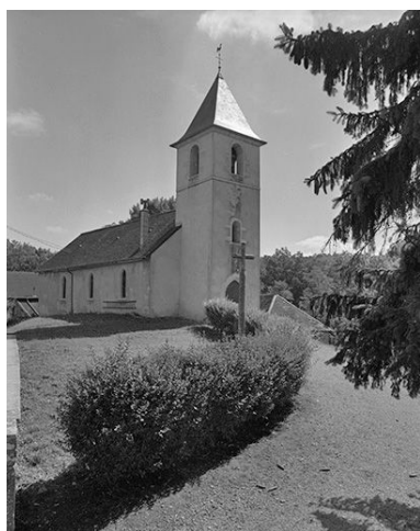
Façades antérieure et latérale gauche. Phot. Yves Sancey IVR43_19843900114X
