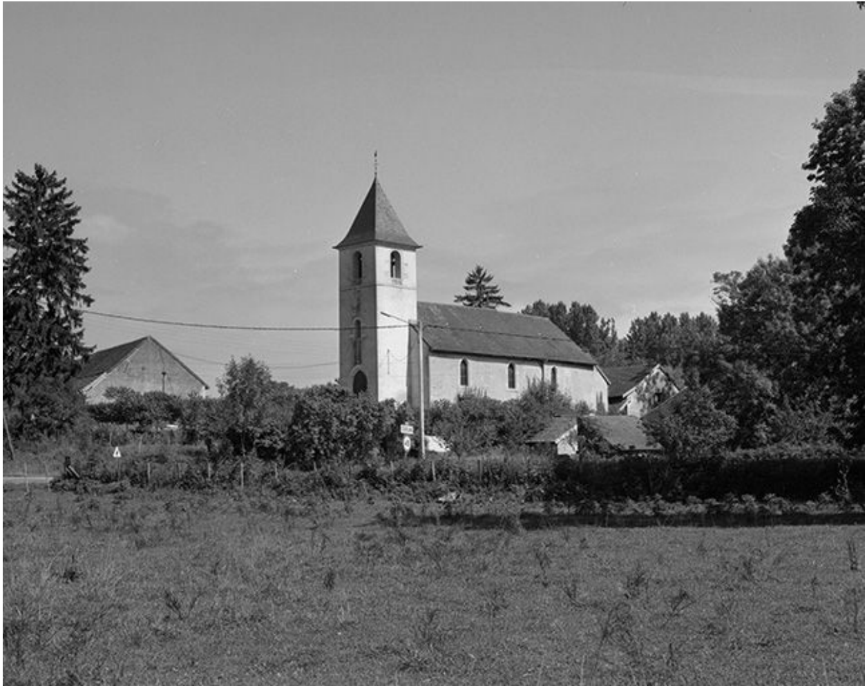
Façades antérieure et latérale droite.
