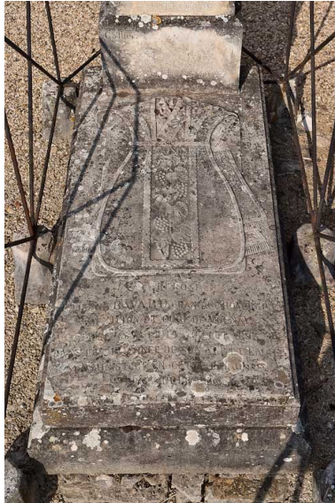
Détail de la dalle.
