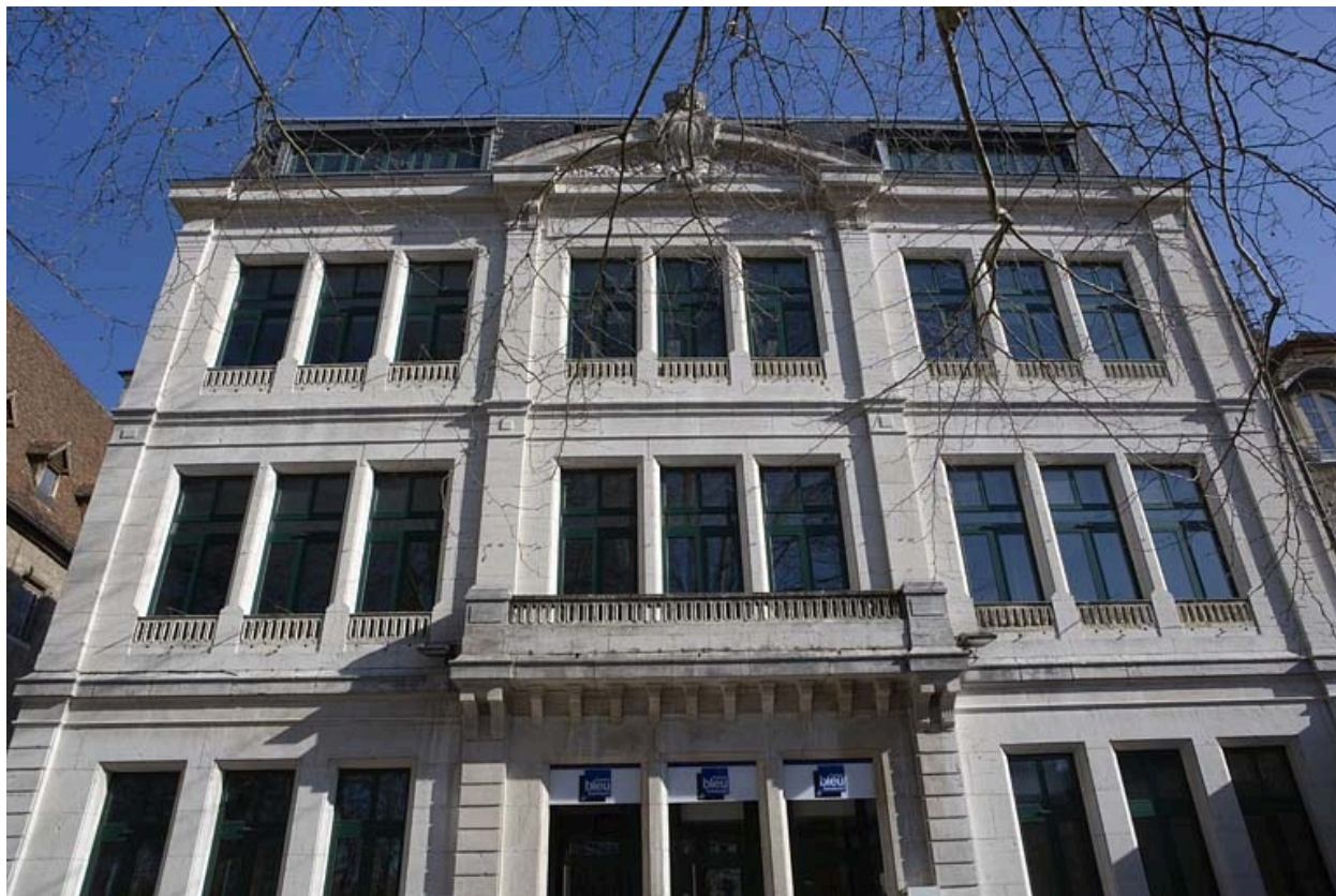
Vue d'ensemble des étages, de face.
