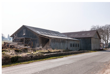
Atelier de sciage depuis le nord-est. Phot. Jérôme Mongreville IVR43_20152500419NUC4A
