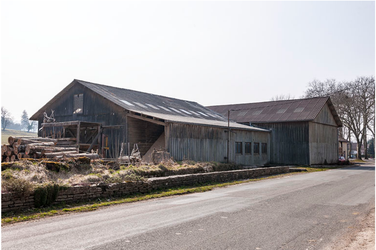
Atelier de sciage depuis le nord-est.
