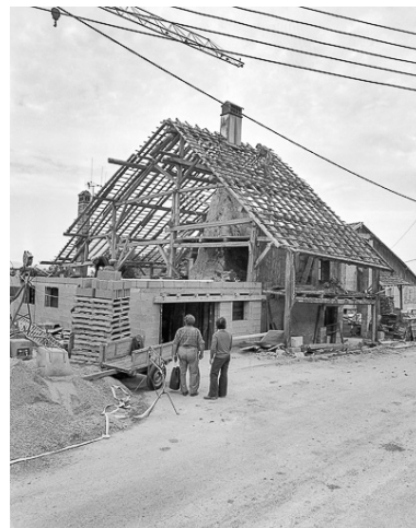
Ferme en cours de rénovation : vue de la charpente. Phot. Bernard Lardière IVR43_19782500350X
