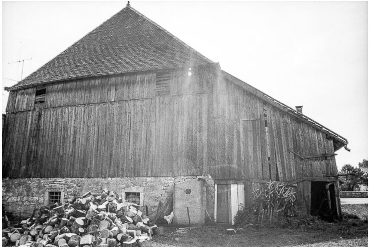
Ferme cadastrée 1962 E 80 : façade latérale (?).
