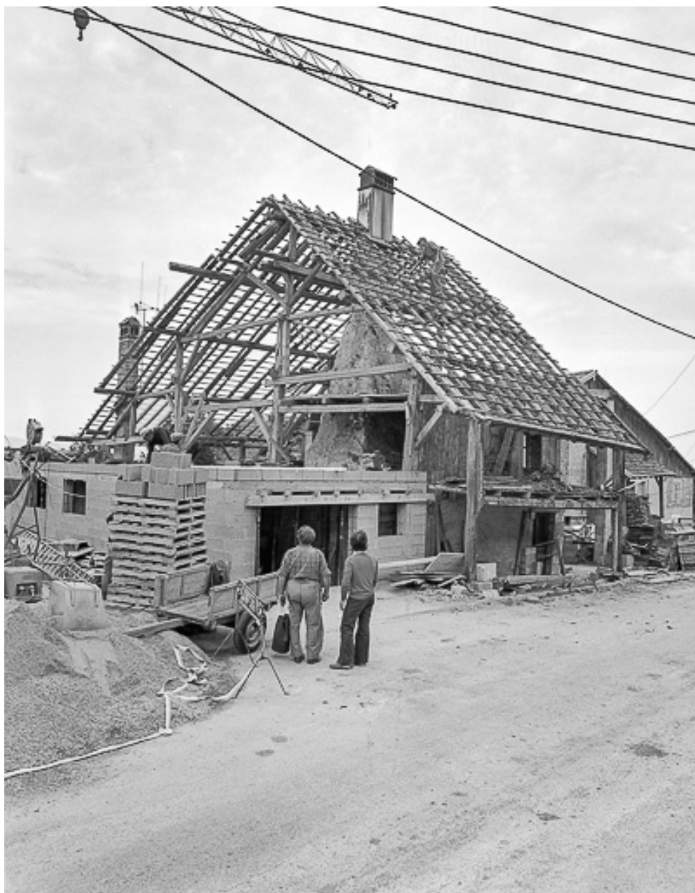
Ferme en cours de rénovation : vue de la charpente.
