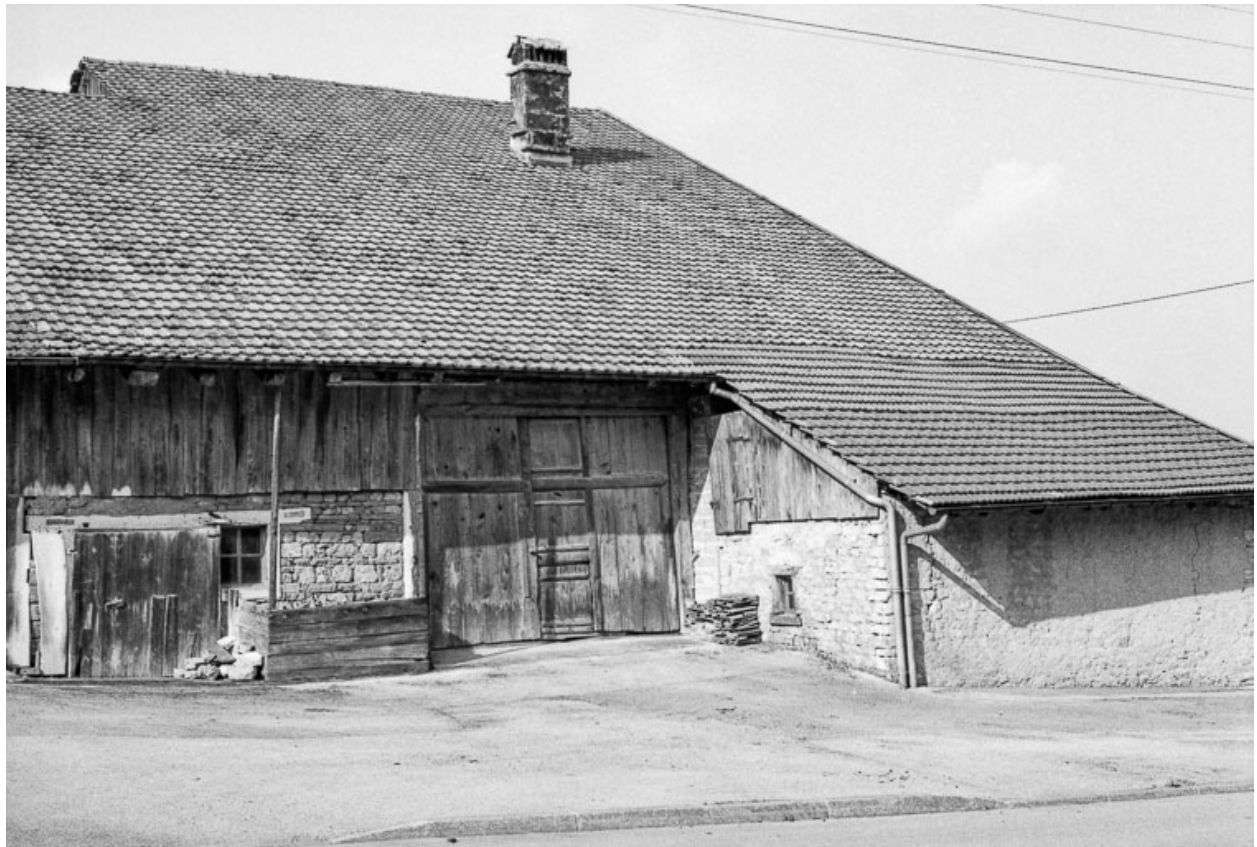
Ferme cadastrée 1962 E 182 : façade latérale droite (?).
