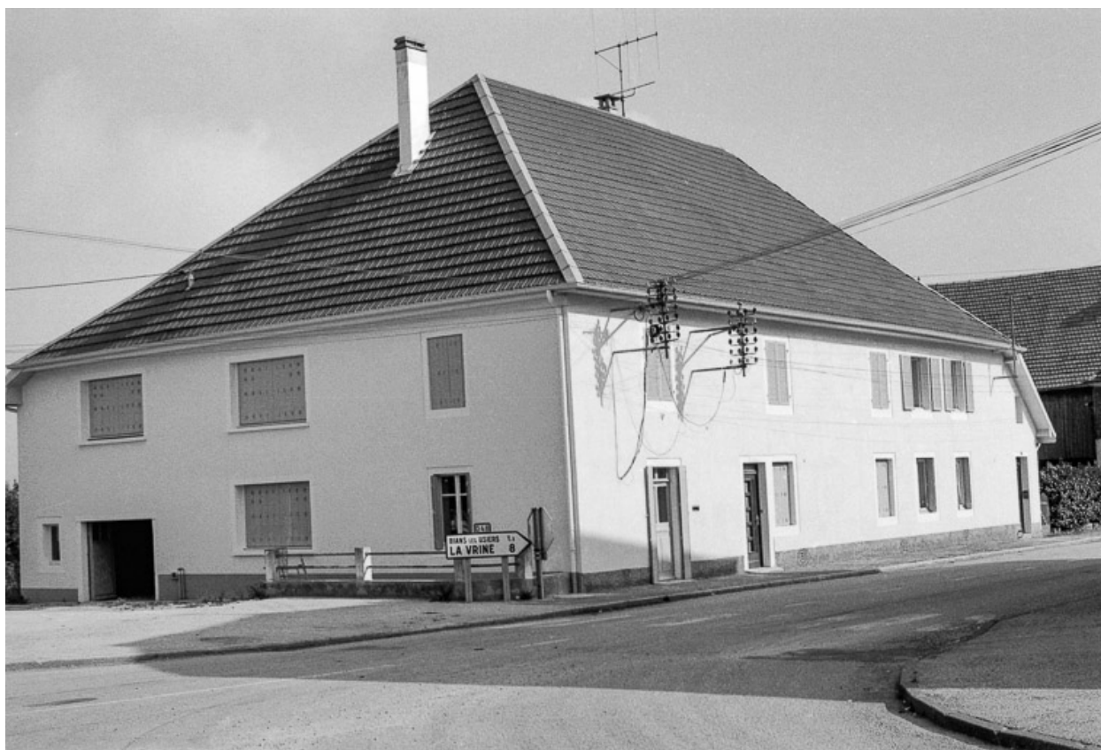
Ferme : façade antérieure et latérale gauche.
