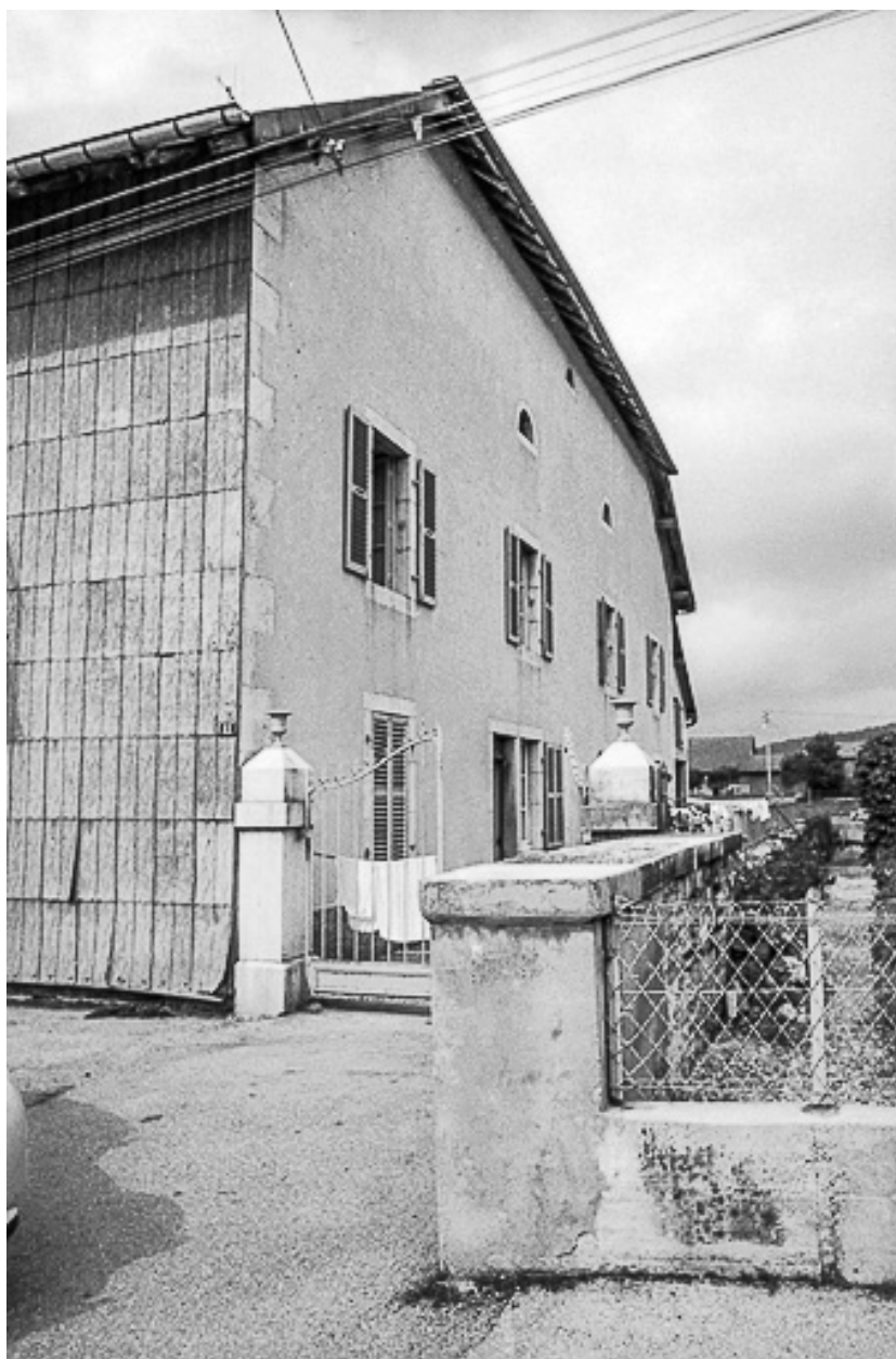
Ferme cadastrée 1962 E 281 bis : façade antérieure.
