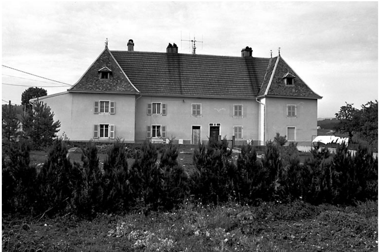
Ferme située 18 Grande Rue : façade de la partie d'habitation traitée en façade de "château".
