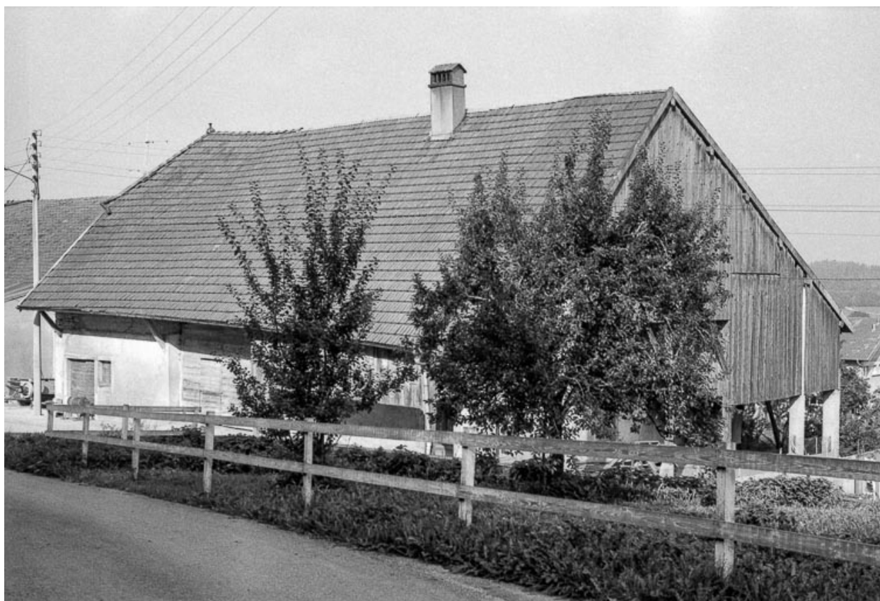
Ferme cadastrée 1962 E 189 : vue d'ensemble.
