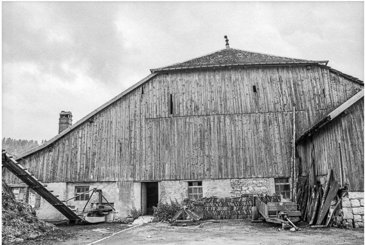
Ferme située 18 Grande Rue : partie agricole.
