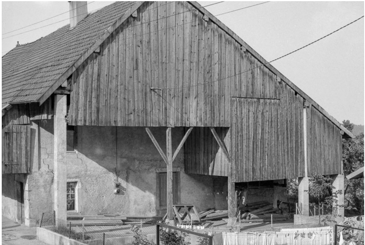
Ferme cadastrée 1962 E 189 : façade latérale droite.
