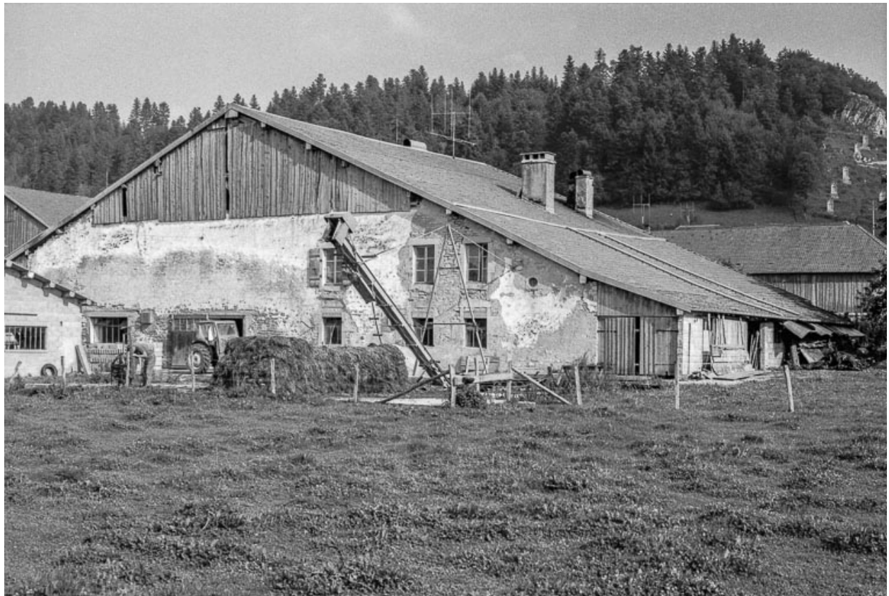
Ferme située 16 Grande Rue : façade postérieure.
